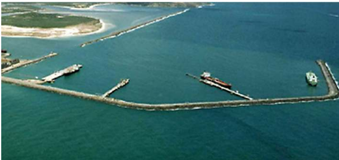
FIGURA 5 - Vista do Cais do Porto de Suape Fonte: SUAPE (2007).
