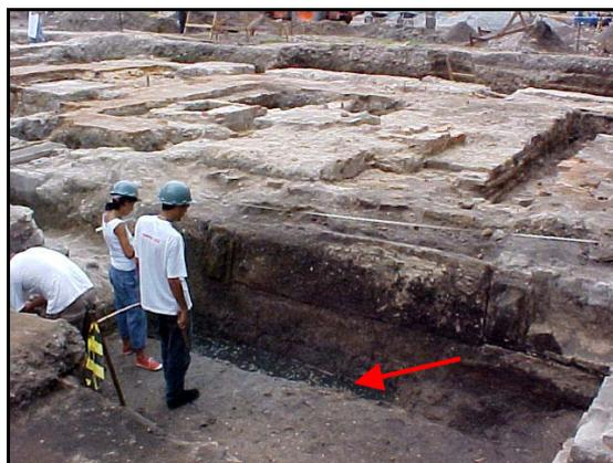
**FIGURA N. 49** – Na seta vermelha, afloramento do lençol freático no trecho da cortina. Essa linha d'água variava juntamente com a maré. (Foto do autor).
