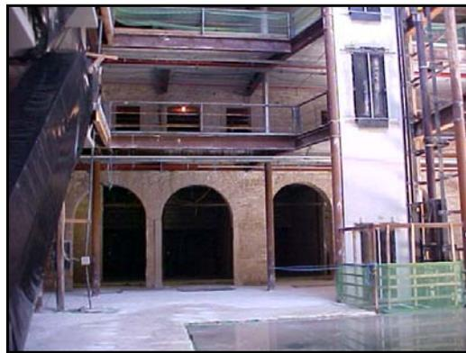
**FIGURA N. 22** – Obras do Paço Alfândega. Mostrando a mesma parede da figura n. 21. Em primeiro plano (na direita) temos a instalação do atual elevador panorâmico do Paço Alfândega (foto do autor).
