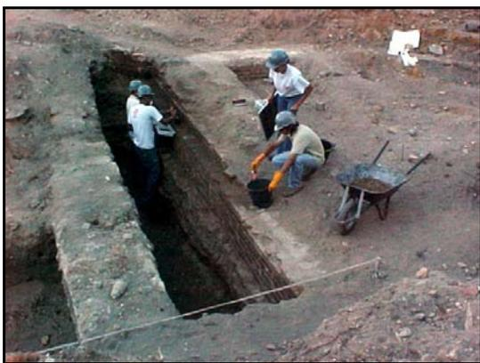
**FIGURA N. 61**– Duas fundações localizadas na praça d'armas. À esquerda fundações do século XIX, à direita fundações de alvenaria do prédio neoclássico construído após 1920 (foto do autor)
