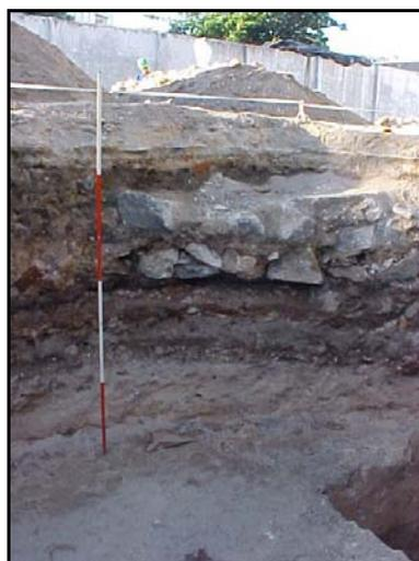
**FIGURA N. 53** – Fundações de granito do século XX nos aterros da praça d'armas. A última camada é nível original da praça d'armas (foto do autor)
