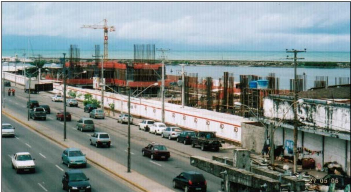
FIGURA 5 – Obra das torres do Cais de Santa Rita na fase de concretagem (2ª laje), com “vizinhança” sob as marquises.
