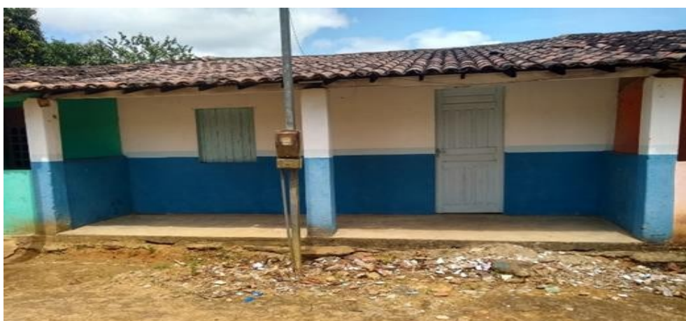
Fotografia 11 – Fachada da Escola Municipal Manoel Rosa da Silva
