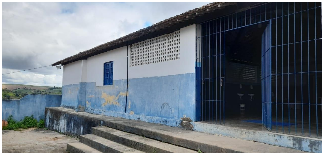
Fotografia 19 – Fachada da Escola Municipal Otacílio Severino dos Santos
