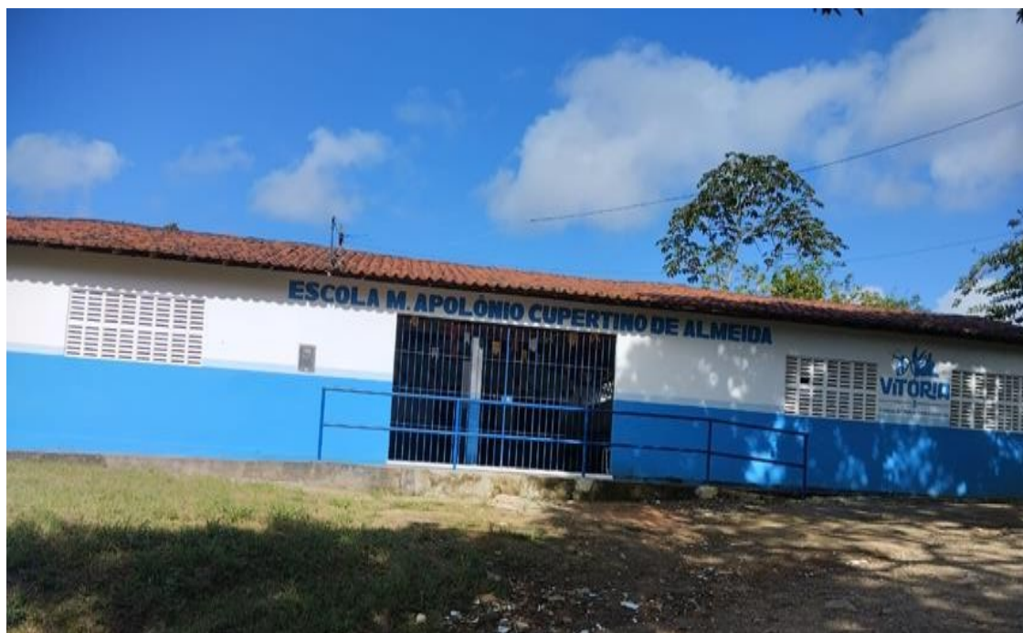
Fotografia 8 – Fachada da Escola Municipal Apolônio Cupertino de Almeida
