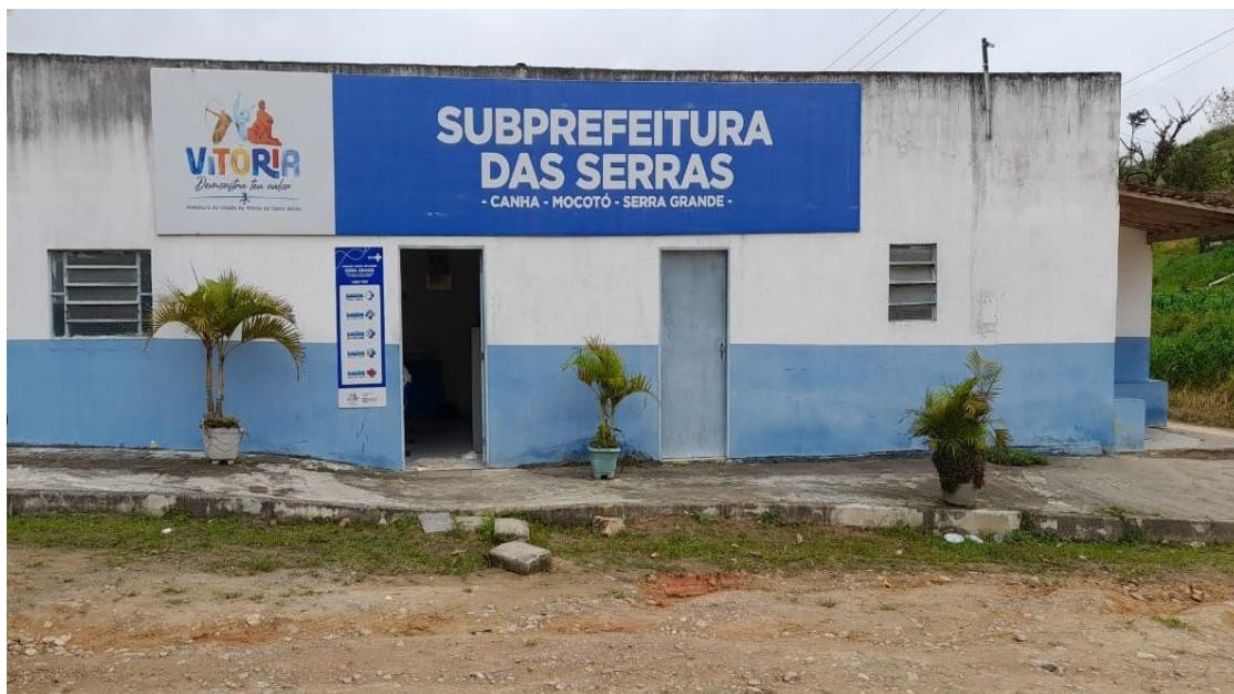
Fotografia 20 – Fachada da Subprefeitura das Serras (Canha, Mocotó e Serra Grande)
