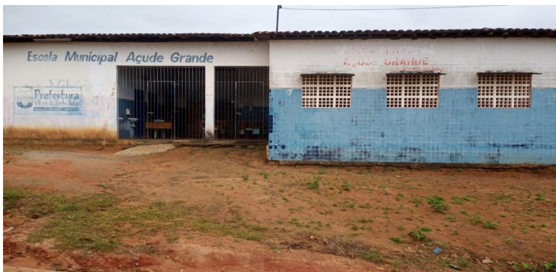
Fotografia 16 – Fachada da Escola Municipal Açude Grande
