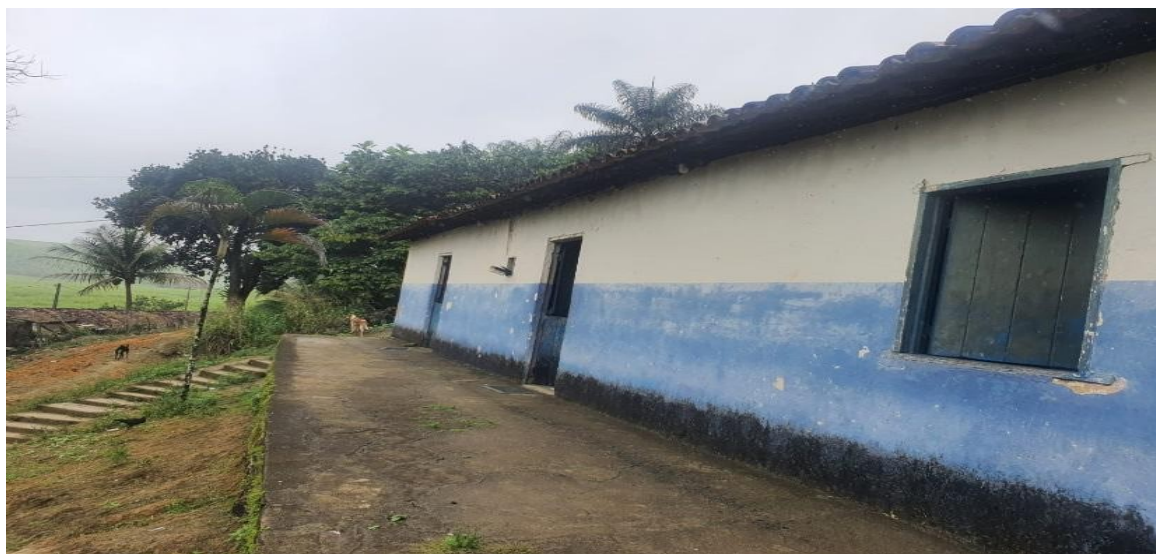
Fotografia 14 – Fachada da Escola Municipal Nossa Senhora do Rosário
