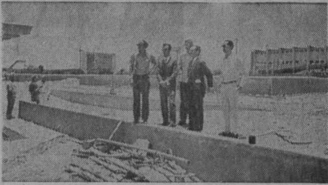
O Pró-Reitor Armando Samico mostra as obras do Centro Esportivo à Comissão do MEC
