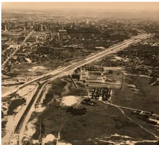
93. Alcir Lacerda Vista da Av. Agamenon Magalhaes (em construção), seu extremo norte, abaixo à direita está a Fábrica Tamaruna, 1970.
