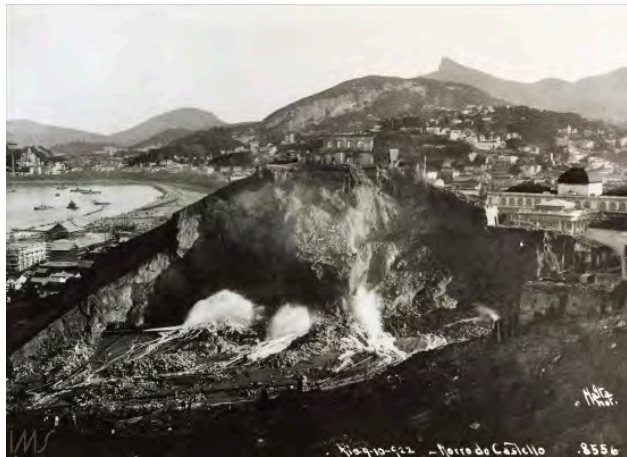
08. Augusto Malta. Demolição do Morro do Castelo, Rio de Janeiro, 9 de outubro de 1922.
