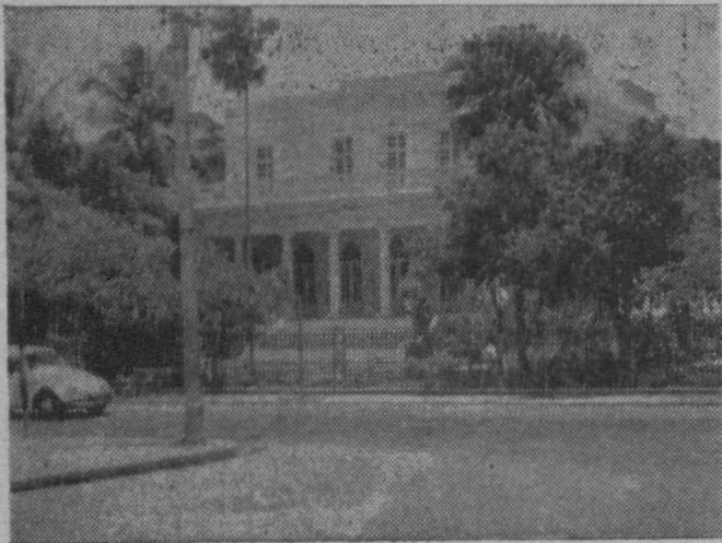
Fachada do prédio onde está instalado o Museu, à avenida Rui Barbosa, 960.
