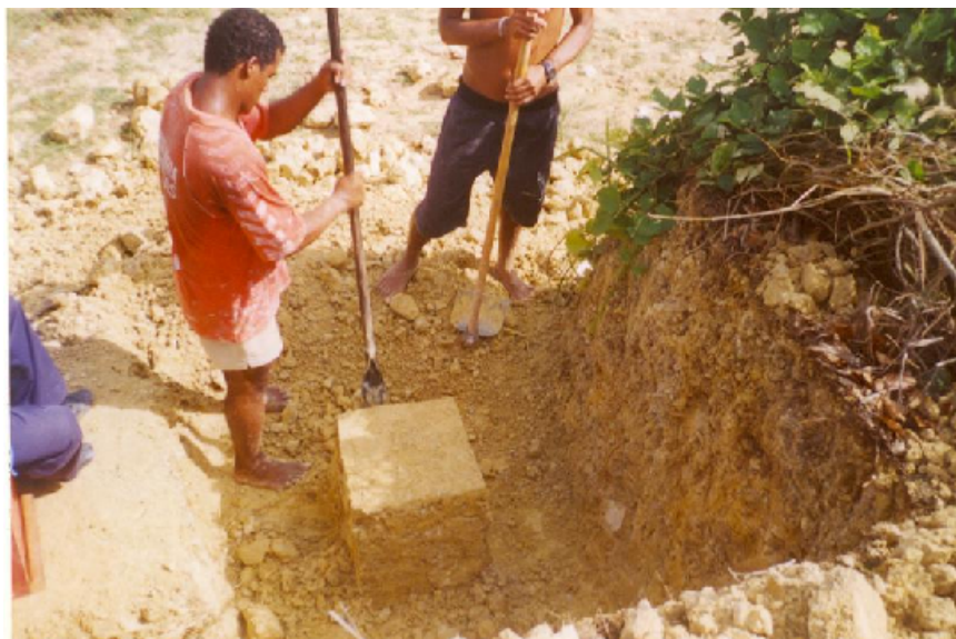
Figura 3.13. Moldagem do bloco.
