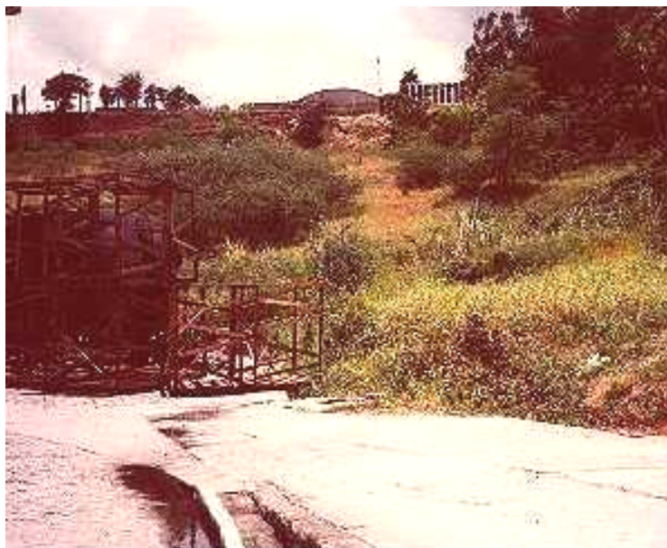
Figura 3.4. Vista geral da Encosta Continental.
