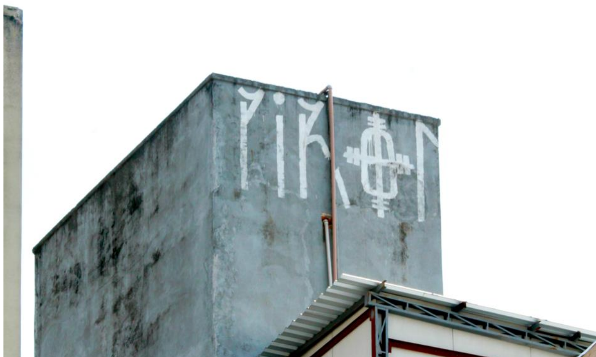
Figura 4.52. PIRON (?) com extensor na modalidade prédio. Imagem registrada em São Paulo/SP, em 2019. Fonte: autora.
