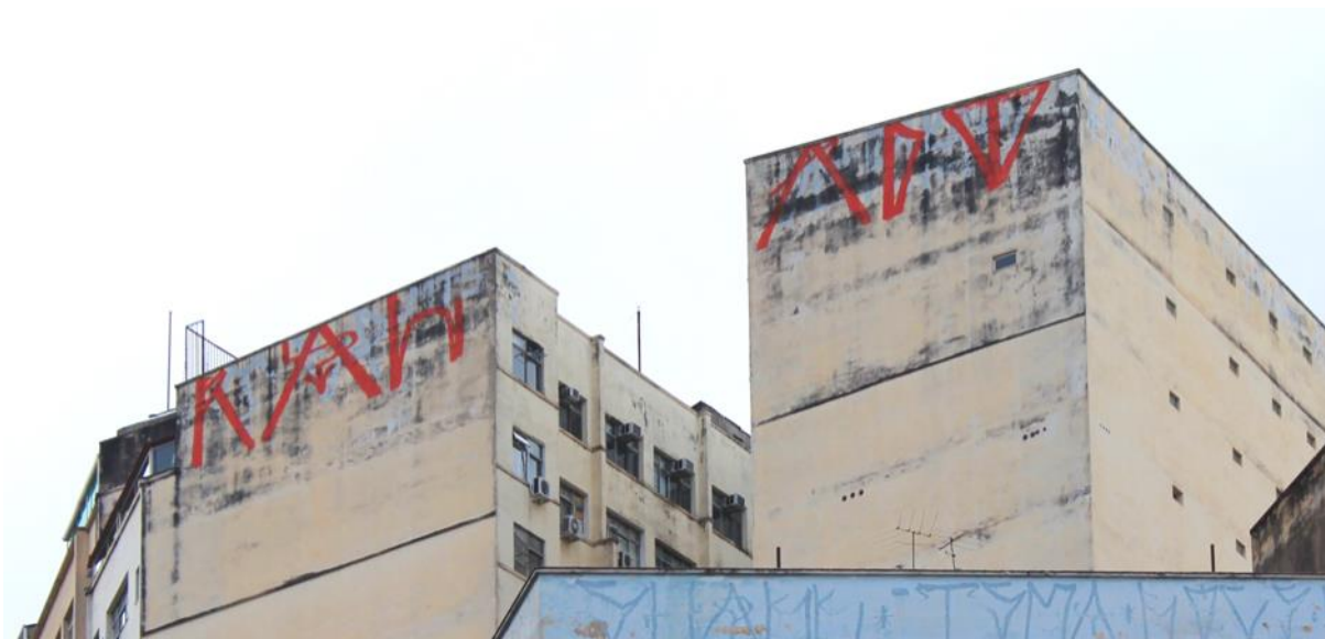
Figura 5.12. RALADO na modalidade prédio. Imagem registrada em Belo Horizonte/MG, em 2021. Fonte: autora.
