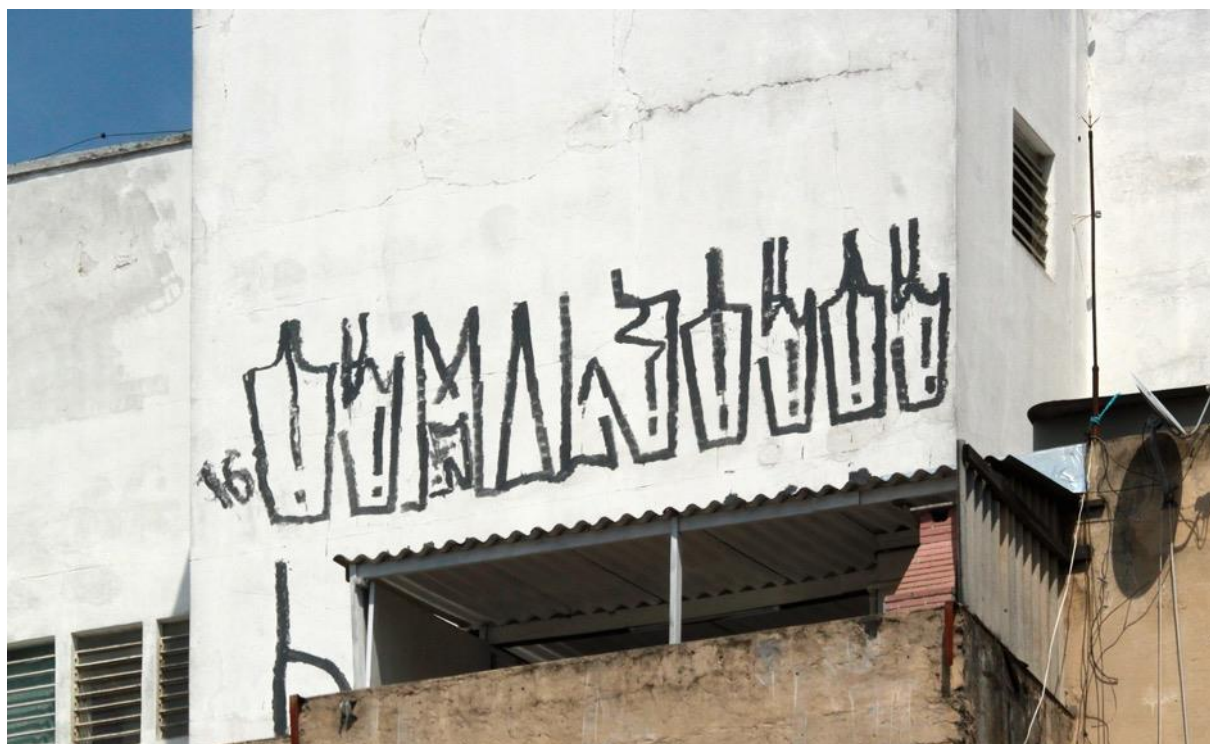
Figura 4.51. OS MALDOSOS com extensor na modalidade beiral. Imagem registrada em São Paulo/SP, em 2019. Fonte: autora.
