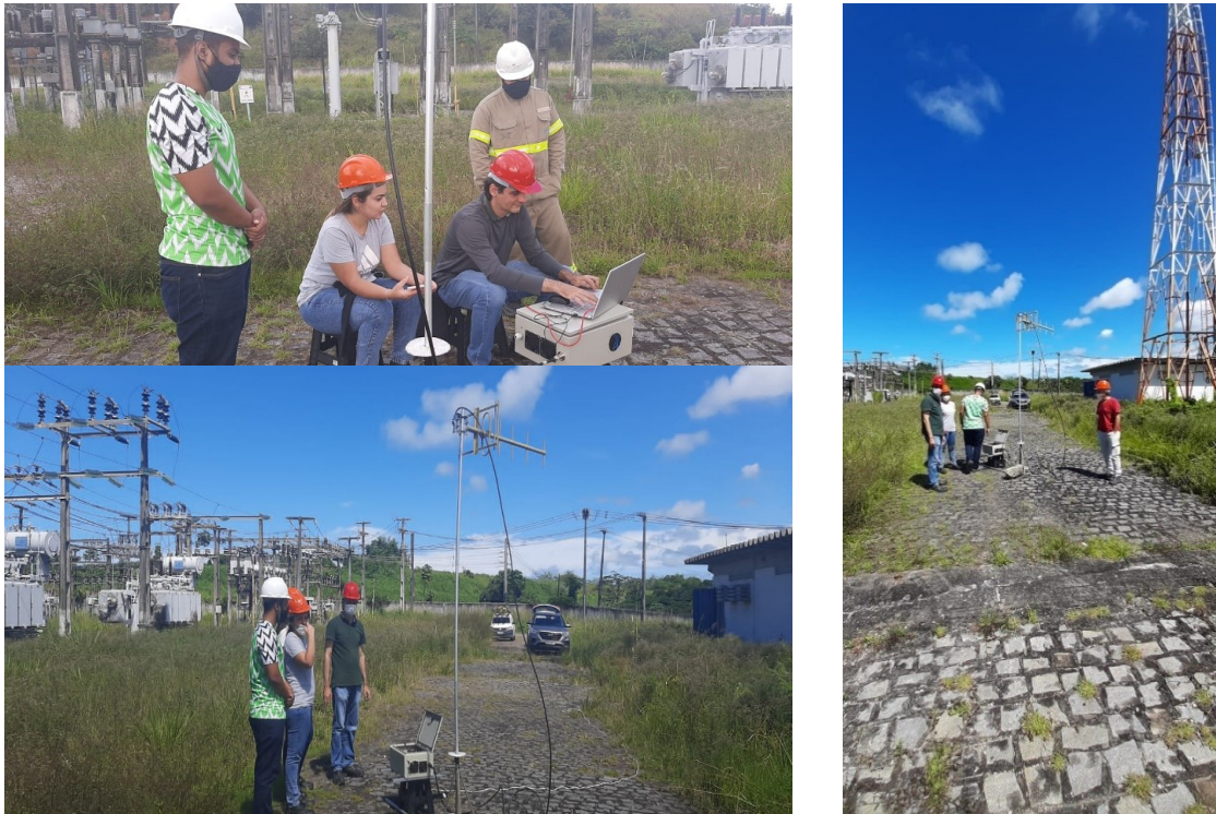
Figura 111- Teste de curta distância da caixa instalada em frente ao Arranjo 2
