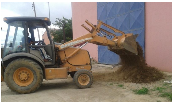
Figura 10 - Retro escavadeira, utilizada para a extração do solo.
