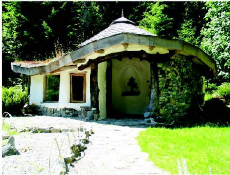
Figura 6 - Casa de COB
