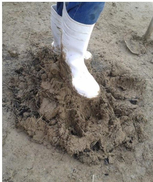
Figura 24 - Amassamento final do traço.
