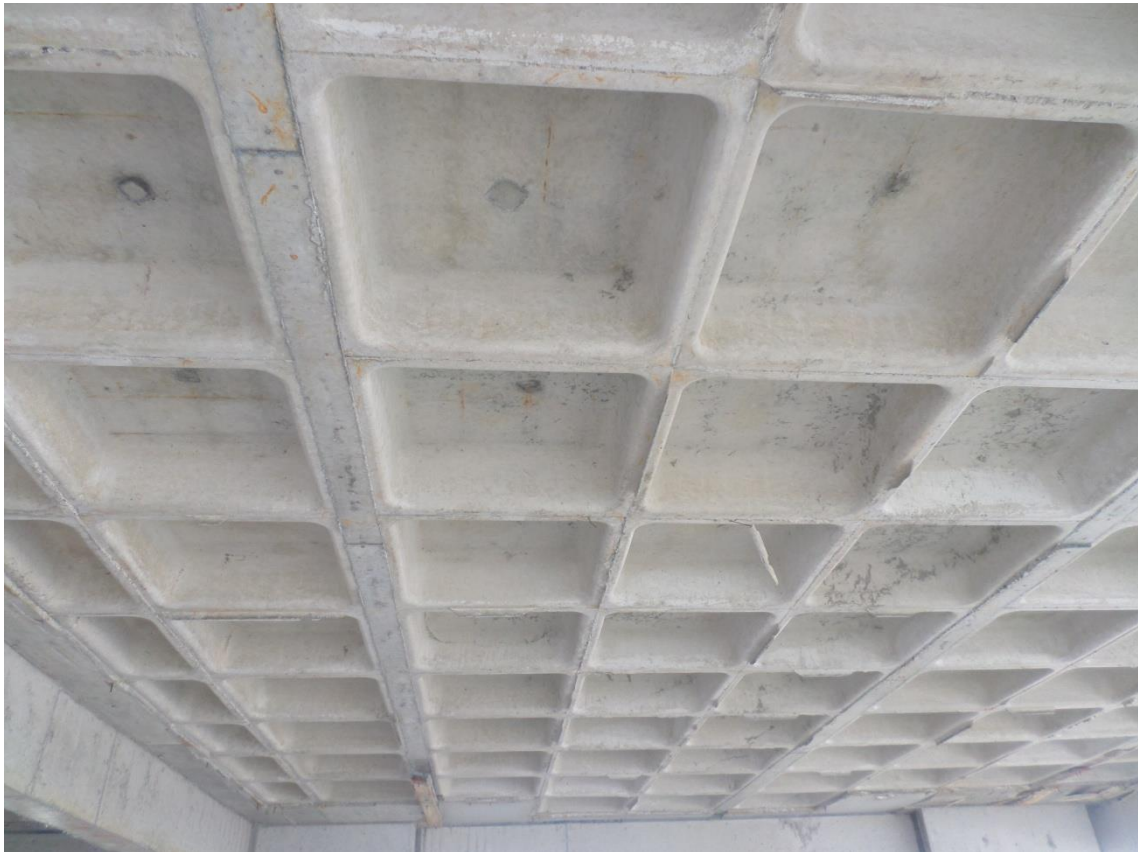
Figura 10 - Laje moldada no local (do Autor, 2014)
