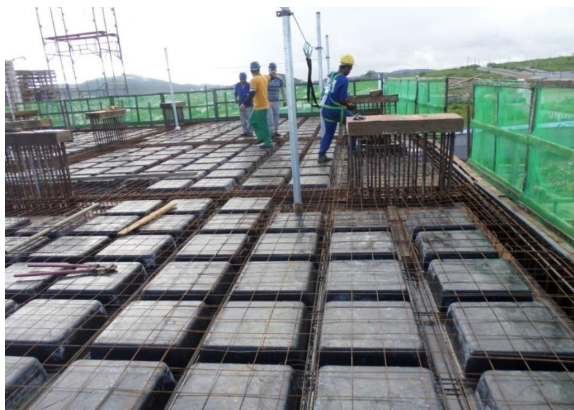
Figura 12 - Laje nervurada moldada no local com uso de forma de polipropileno (do Autor,2014)
