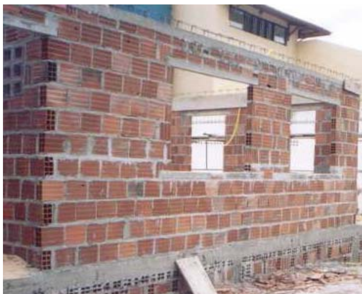
Figura 2.13 (b) – Alvenaria de vedação com função estrutural
