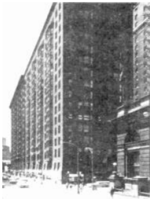
Figura 2.14 (c) – Edifício Monadnock – EUA
