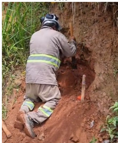
Figura 38 – Utilização de vanca com um cabo de 40 cm para facilitar o operador a esculpir o bloco de solo
