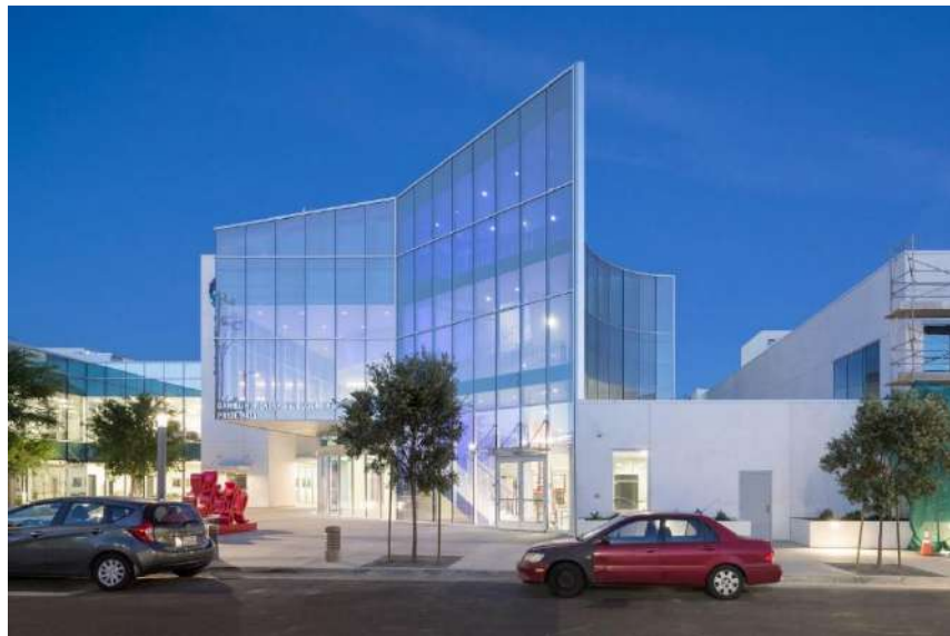
Figura 18 - Fachada Oeste do bloco do Centro da Juventude.
