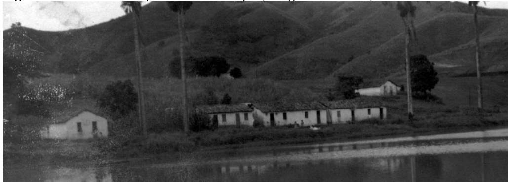
Figura 18: Arruado 01 e açude na usina Tanques, Alagoa Grande-PB, 1979.
