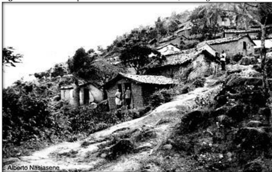
Figura 14: Casas de taipa no bairro Morro do Cruzeiro, em Alagoa Grande-PB, 1979
