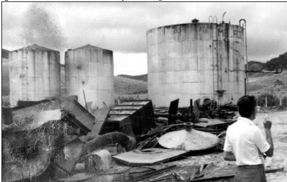
Figura 11: Reservatórios da Usina Tanques em Alagoa Grande-PB, 1979
