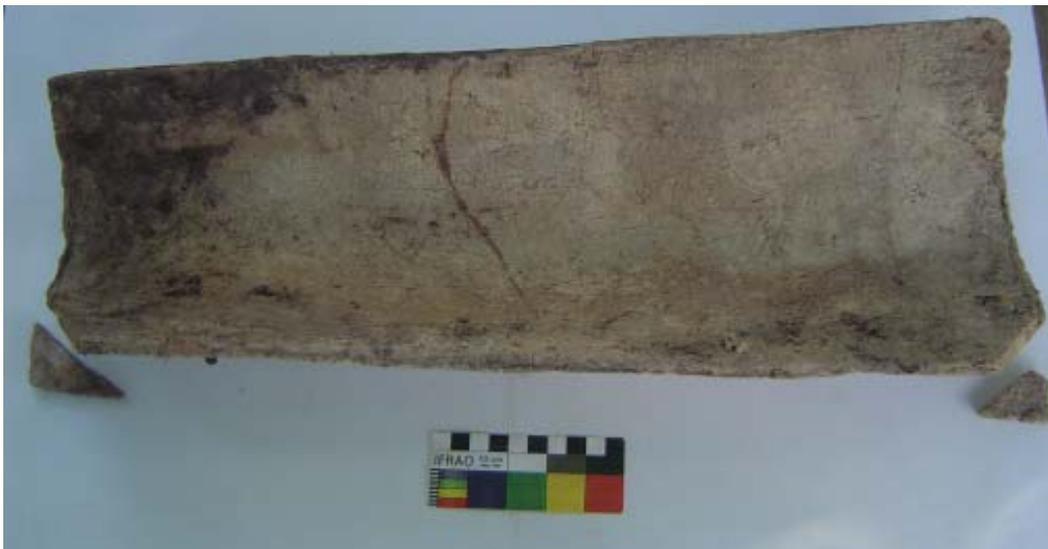
Foto 73: Telha de barro utilizada como verga de abertura, observar o material calcário aglutinado.
