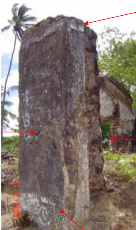
Ao todo, são oito pilares que utilizam essa técnica construtiva, dos quais só um não mais existe, devido à utilização do espaço como via, por pessoas, animais e veículos. Esses pilares recebem um reboco que reveste a parte externa, com uma espessura de mais ou menos 1,5cm, composto por uma mistura à base de cal; na parte interna a estrutura fica aparente.
