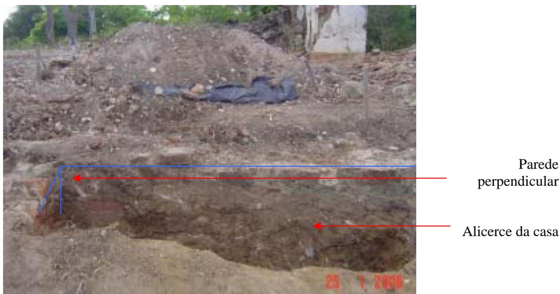
Foto 6: Alicerces da parede e parede perpendicular.
