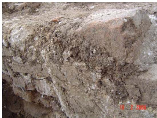
Foto 20: Lateral da escada, reboco e cal.
