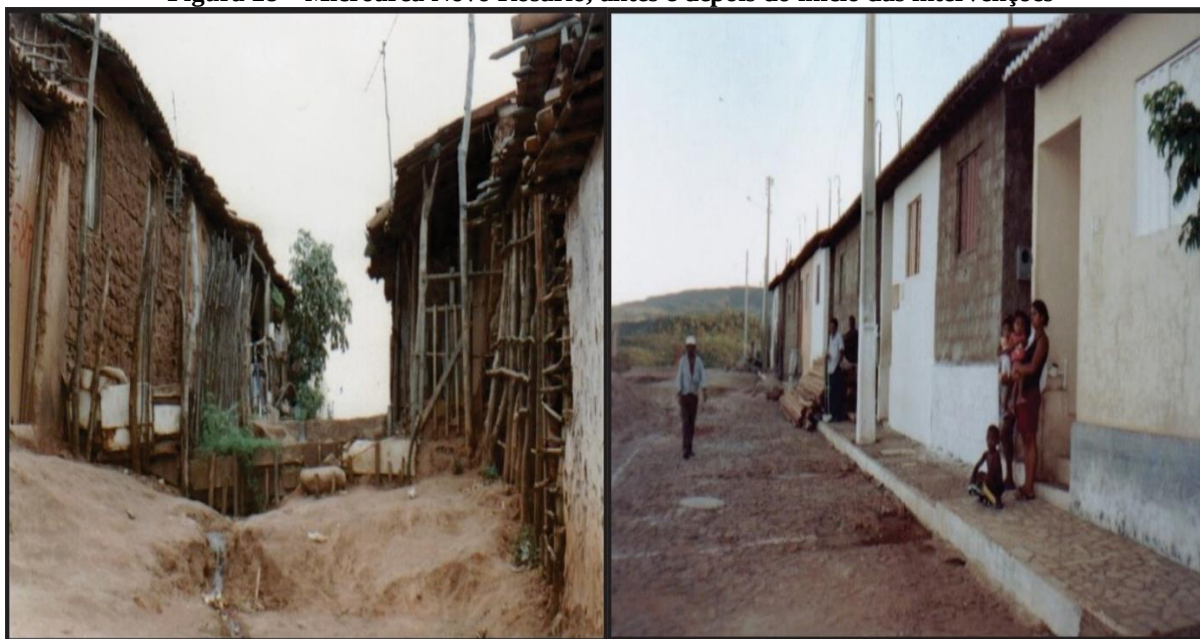
Figura 28 – Microárea Novo Rosário, antes e depois do início das intervenções
