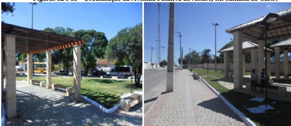
Figuras 52 e 53 – Urbanização da Avenida Patativa do Assaré, em Santana do Cariri
