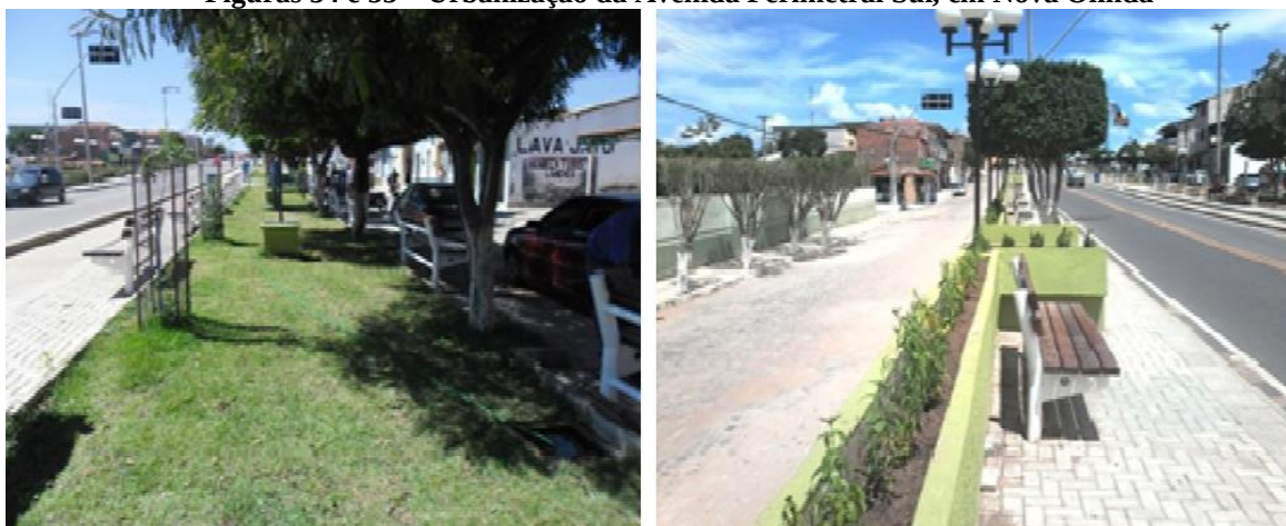
Figuras 54 e 55 – Urbanização da Avenida Perimetral Sul, em Nova Olinda
