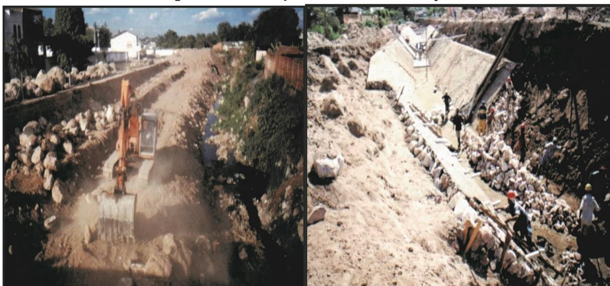
Figura 23 – Intervenções no Canal do rio Granjeiro
