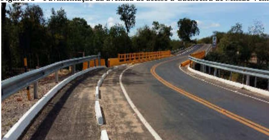
Figura 73 – Pavimentação da avenida de acesso à Cachoeira de Missão Velha
