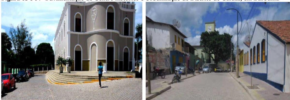
Figura 63 e 64– Pavimentação do Centro histórico e Urbanização do Distrito do Caldas, em Barbalha
