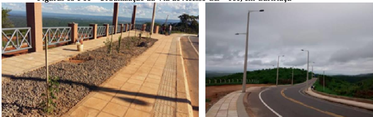
Figuras 65 e 66 – Urbanização da Via de Acesso CE – 060, em Caririaçu
