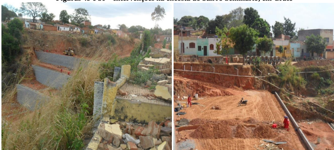
Figuras 49 e 50 – Intervenções na encosta do bairro Seminário, em Crato
