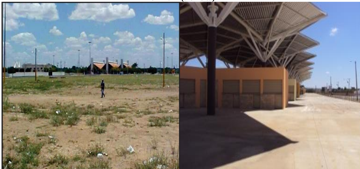
Figura 27 – Terreno destinado à construção do centro de apoio ao romeiro (esquerda) e a obra concluída em 2011 (a direita)
