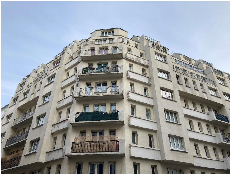
Figure 5 : Façade existant bâtiment 7 Av. Corbera Source : Croixmariebourdon architectes
