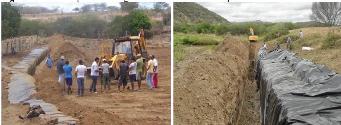
Figura 13 - Construção das barragens subterrâneas no município de Cabaceiras/PB
