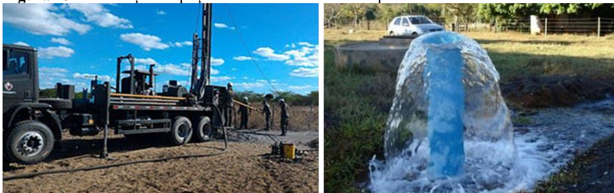
Figura 15 - Perfuração de poços na zona rural do município de Cabaceiras/PB
