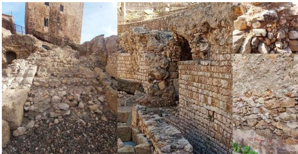
Figura 63: Tecnologia construtiva de pedra argamassada no Centro Histórico de Tánger, Marrocos.
