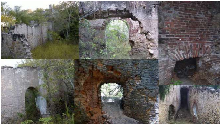
Figura 91: Alvenarias de pedra argamassada e tijolos em Forno da Cal, Abreu e Lima
