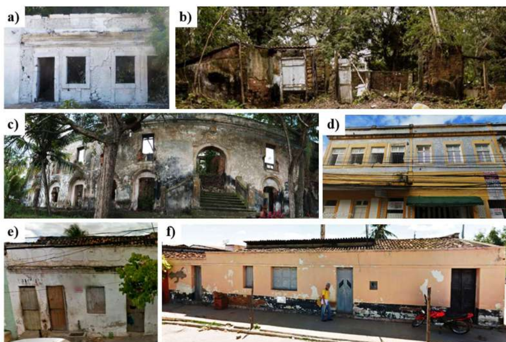
Figura 46: Moradias em estudo de caso nesta tese: (a) casa 01: N° 18, Vila de Nazaré; (b) casa 02: Engenho Jaguaribe; (c) casa 03: Engenho Suassuna; (d) casa 04: N° 246, Barão de São Borja, Boa Vista; (e) casa 05: n° 167, Vertentes; (f) casa 06: N° 319, Araripina
