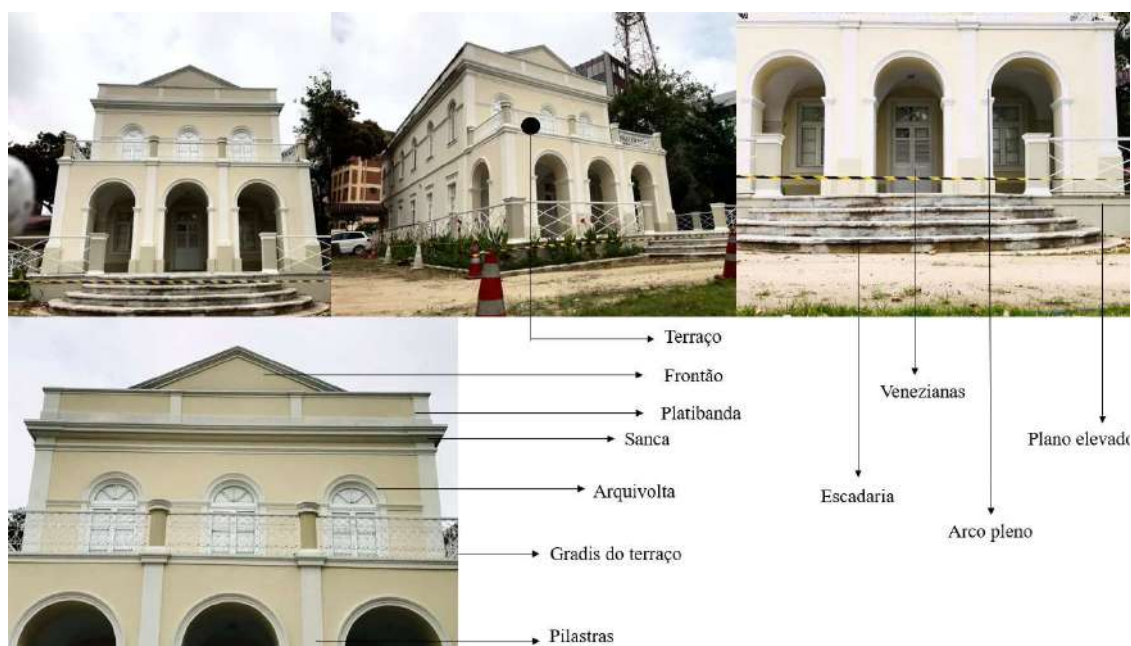
Figura 35: Solar do Manguinho, no bairro das Graças do Recife
