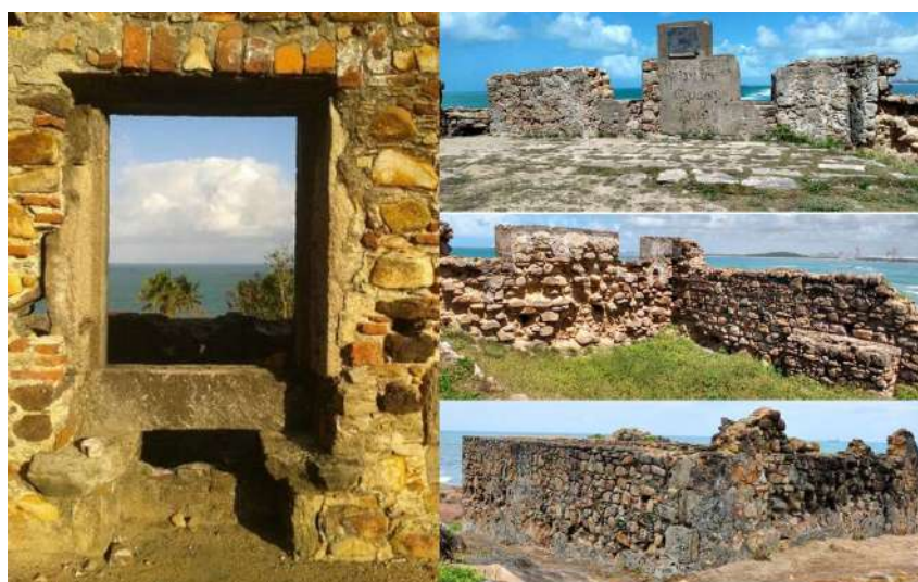
Figura 58: Alvenaria mista e de pedra em aparelho ciclópico presente no Forte Castelo do Mar, Cabo de Santo Agostinho/PE
