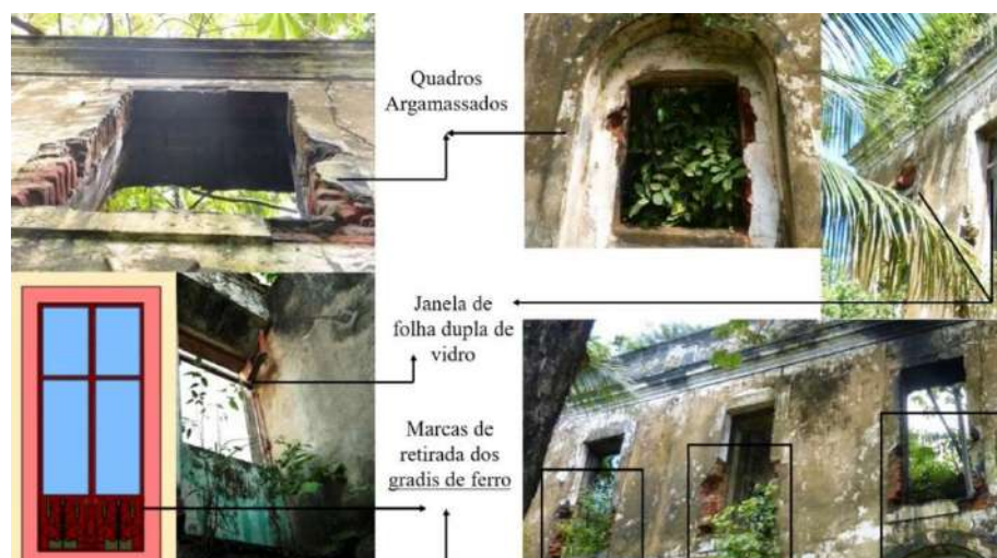
Figura 119: Características das janelas do Engenho Suassuna
