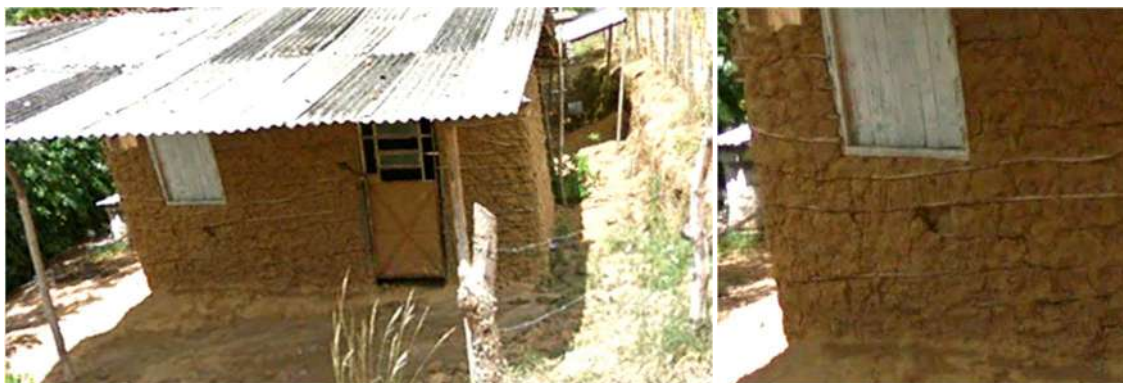
Figura 92: Casa de taipa próximo a olaria entre o engenho Jaguaribe e o Forno da cal
