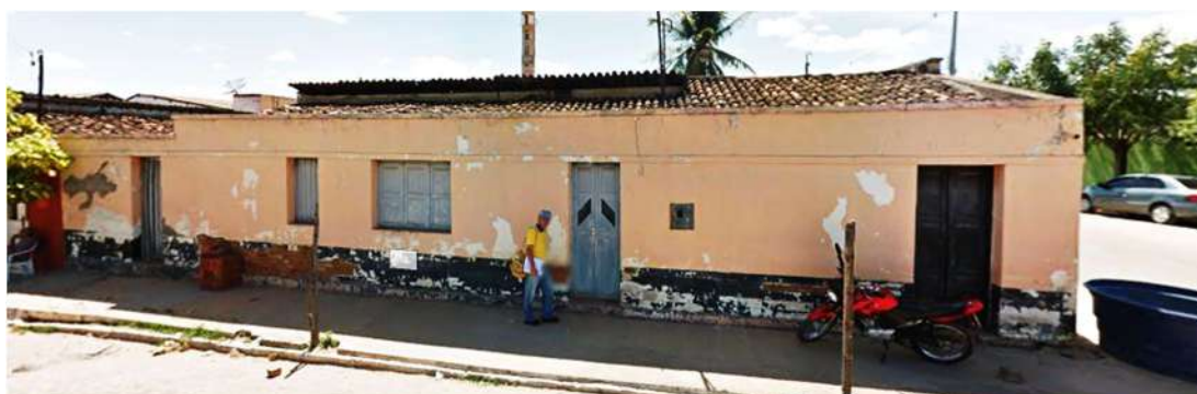
Figura 179: Moradia nº319 da Rua José Arnoud Campos, Araripina
