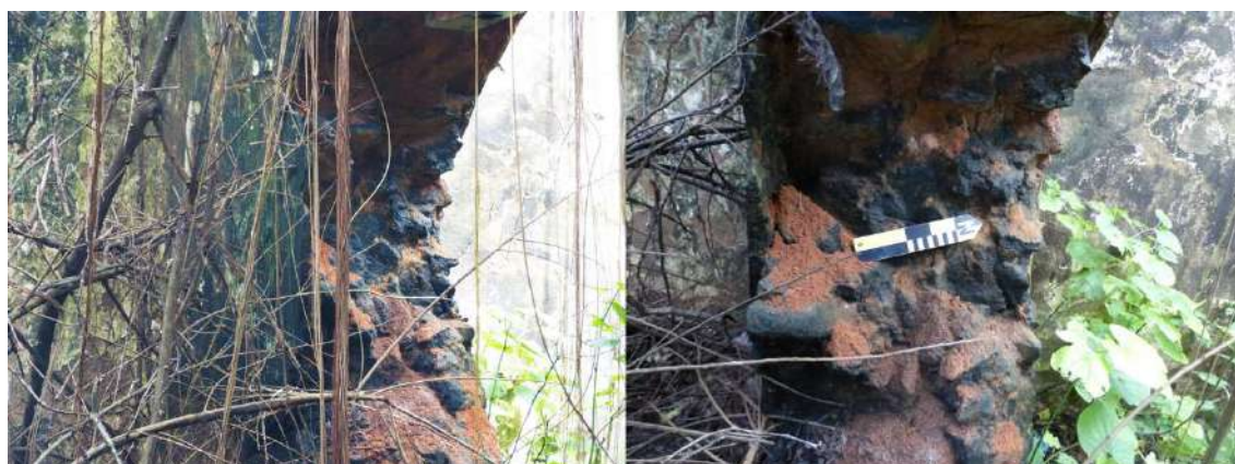
Figura 125: Alvenaria de pedra argamassada
