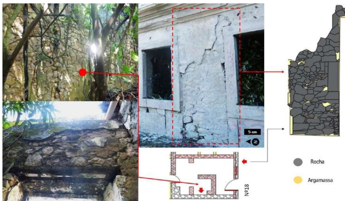
Figura 57: Disposição de alvenaria de pedra em aparelho ciclópico na moradia nº18, estudo de caso da Vila de Nazaré
