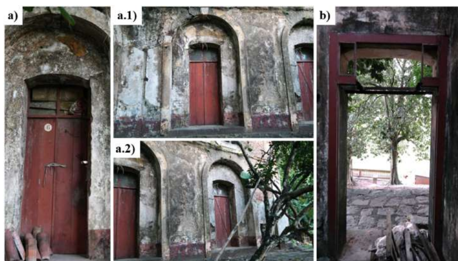
Figura 116: Detalhes das portas do Engenho Suassuna em 2021
