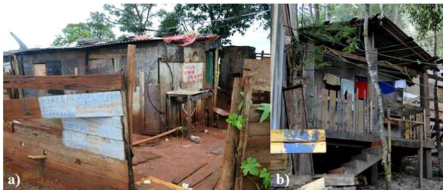
Figura 24: a) Barraco em Curado IV, Recife; b) Barrado em Muribeca, Jaboatão dos Guararapes
