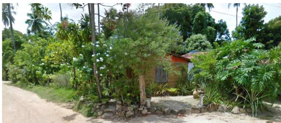
Figura 72: Moradia nº 291 com uso da taipa de pilão como técnica construtiva, associada a uma cobertura de telhas e palha, cerca por plantas como elemento de delimitação do terreno
