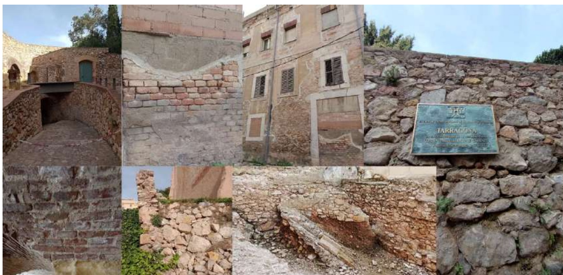
Figura 65: Alvenaria de pedra argamassada e mista no centro histórico de Tarragona, Espanha
