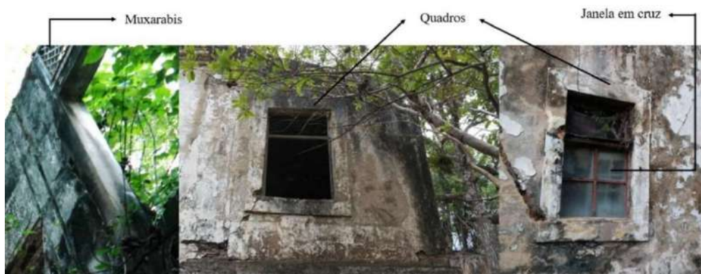
Figura 120: Detalhes das janelas do Engenho Suassuna
