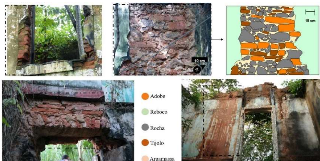
Figura 123: Alvenaria mista de tijolos, adobe e pedra em aparelho irregular
