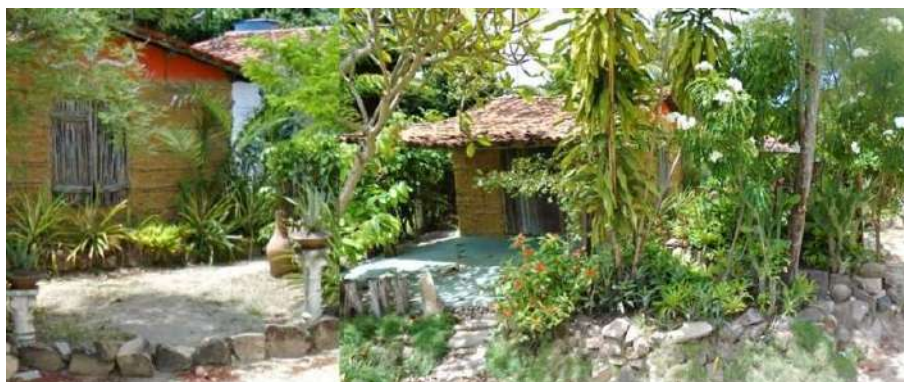
Figura 73: Uso da taipa de pilão como técnica construtiva na moradia nº 291 e 89, respectivamente, associada a uma cobertura de telhas e palha, cerca por plantas como elemento de delimitação do terreno
