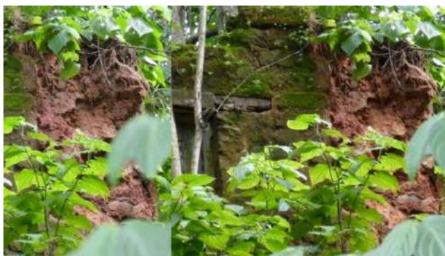
Figura 126: Alvenaria de adobe da casa-grande do Engenho Suassuna
