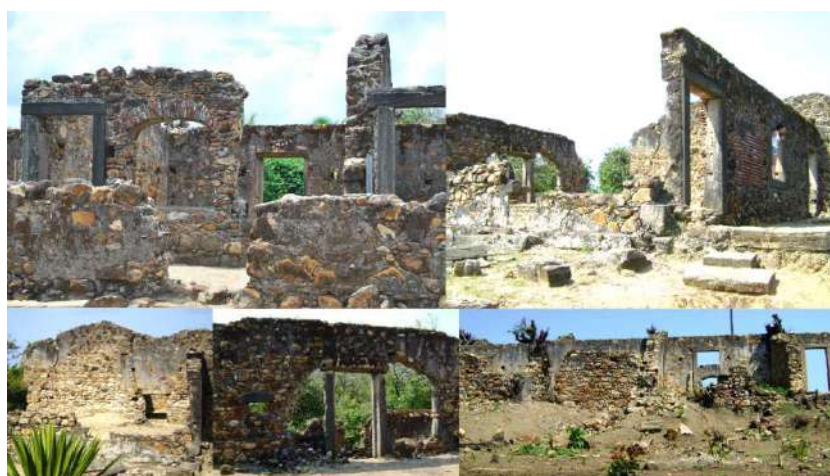
Figura 59: Alvenaria mista e de pedra em aparelho ciclópico presente no Quartel Velho, Cabo de Santo Agostinho/PE
