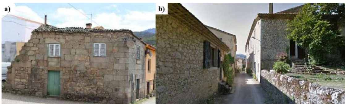
Figura 65: Alvenaria de pedra argamassada e mista no centro histórico de Tarragona, Espanha
