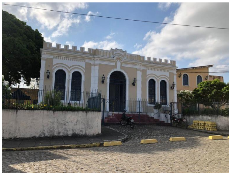
Figura 12 – Prédio administrativo do campus de Vitória – Outubro de 2021
