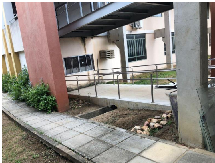
Figura 8 – Rampa que leva a lugar nenhum no campus de Caruaru – Dezembro de 2021
