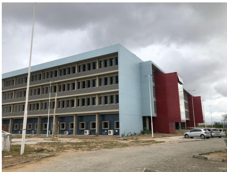
Figura 9 – Visão lateral do prédio do curso de medicina do campus de Caruaru – Dezembro de 2021
