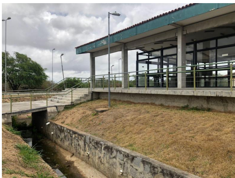
Figura 6 – Visão do esgoto em frente ao restaurante universitário do campus de Caruaru – Dezembro de 2021
