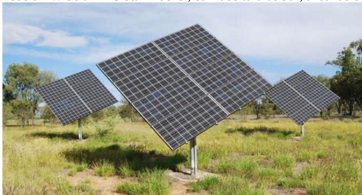
Figura 50 - Sistema Fotovoltaico do sítio 5 do DKASC, composto por cinco rastreadores de eixo simples segmentados, modelo BW Solar F2 5 Star Tracker, com abertura de 90^\circ , andando em passos de 15^\circ
