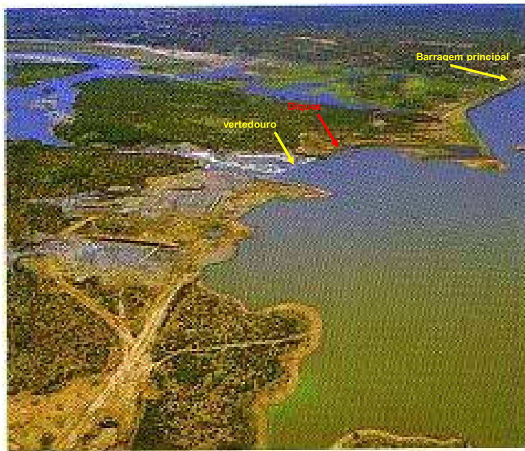
Figura 2.10 – Vista aérea do vertedouro e diques transbordáveis 1 e 2 (DNOCS, 1990).
