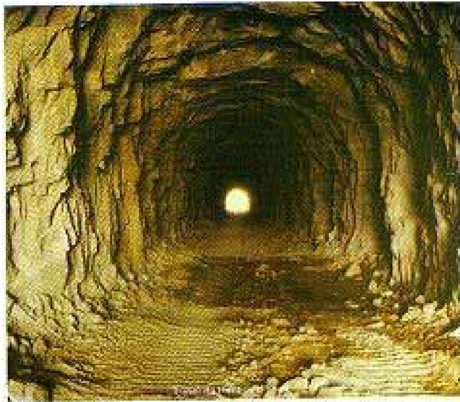
Figura 2.11 – Túnel da tomada d'água escavado na rocha (DNOCS, 1990).
