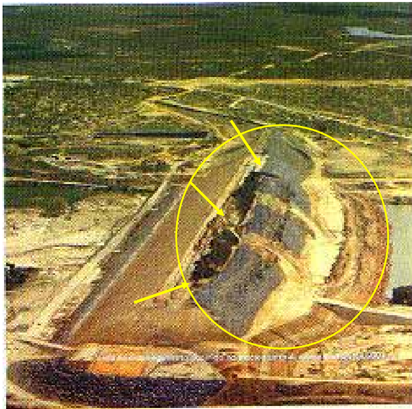
Figura 2.6 – Foto do acidente em final de construção (DNOCS, 1990).
