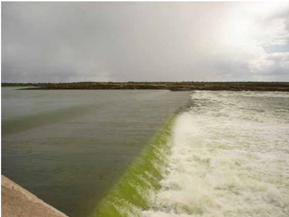
Figura 2.12– Vista do sangradouro em funcionamento na cheia de 2006.
