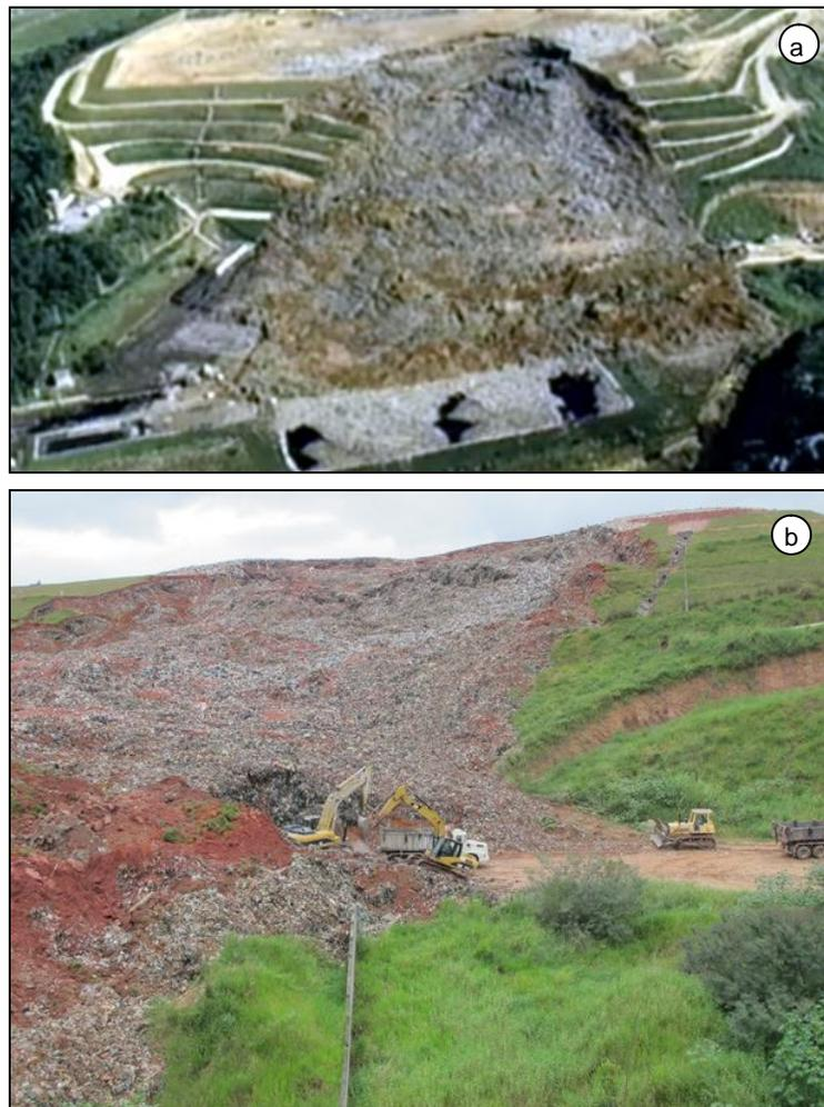
**Figura II.38. Imagem da ruptura do Aterro da Pajoan: (a) vista aérea (TERRATV, 2011) e (b) vista no local (G1, 2011)**
