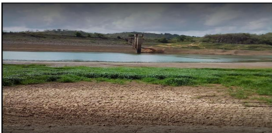
Figura 02- Barragem de Pedra Fina – Bom Jardim/PE.
