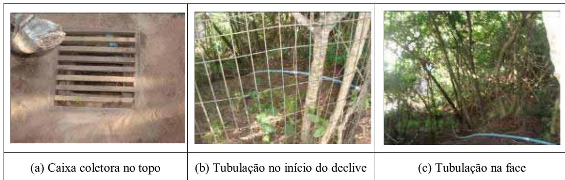
Figura 7.3. Detalhe da caixa coletora de águas pluviais no topo da falésia
