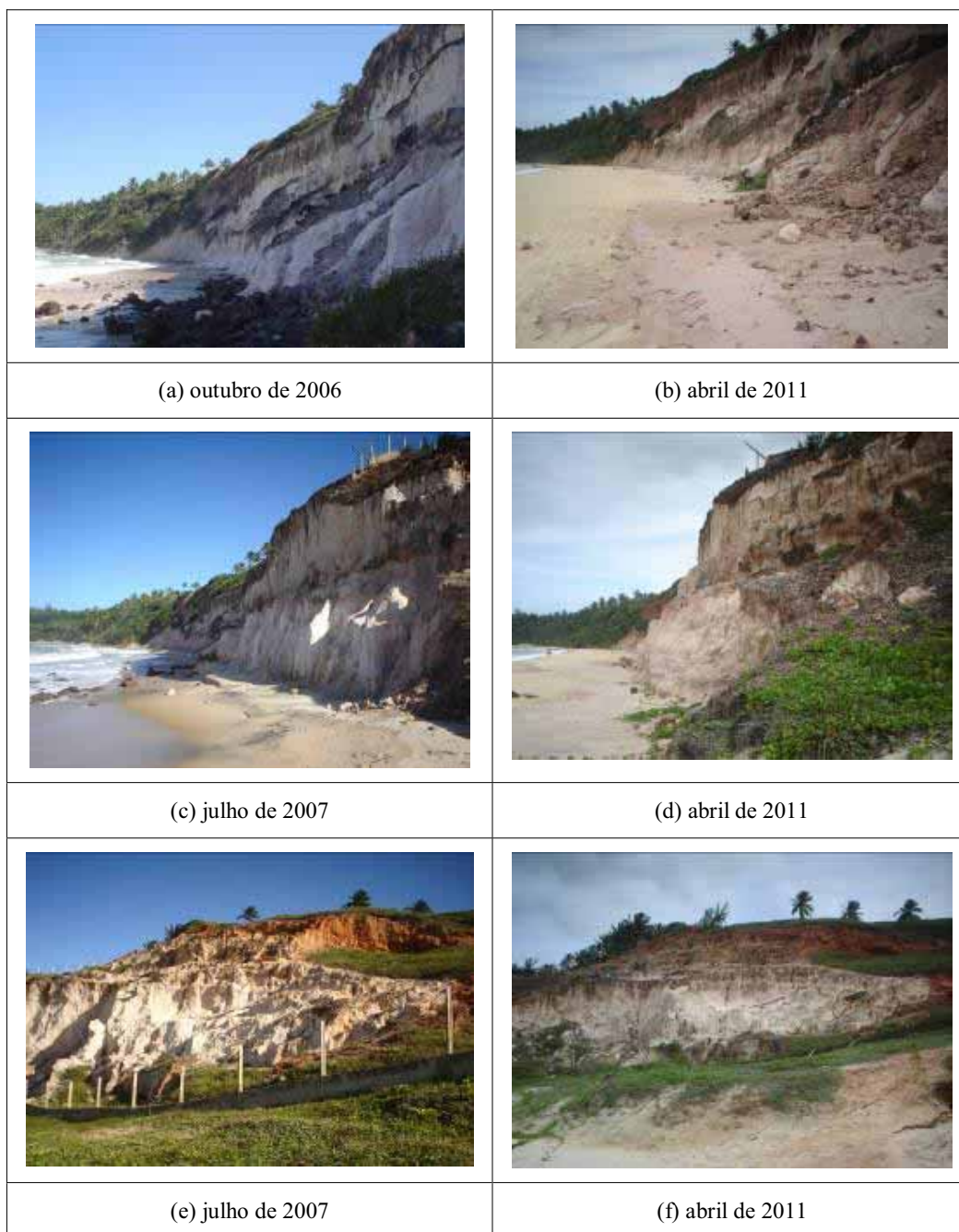
Figura 3.4. Erosão superficial na face da falésia no trecho norte (N01)
