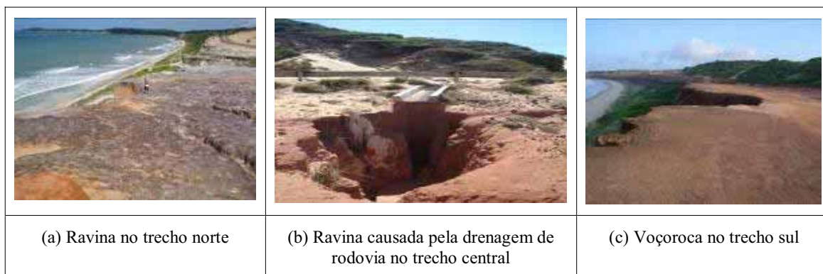
Figura 3.3. Processos erosivos na área estudada (Santos Jr. et al., 2008)
