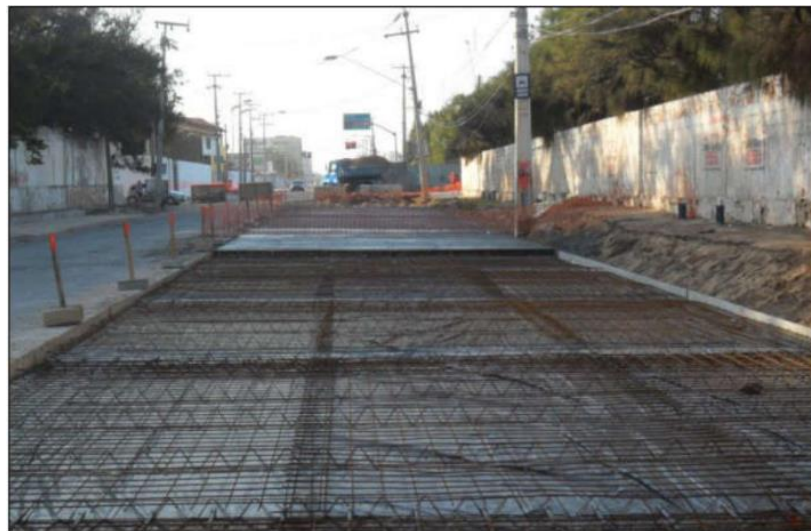
Figura 7 - Detalhe da armadura de pavimento rígido antes da concretagem
