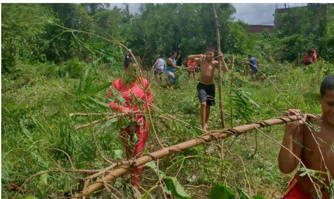
Figura 29: Um dos mutirões de limpeza realizados no terreno. . Fonte: Setor de Arquitetura do MTST-PE
