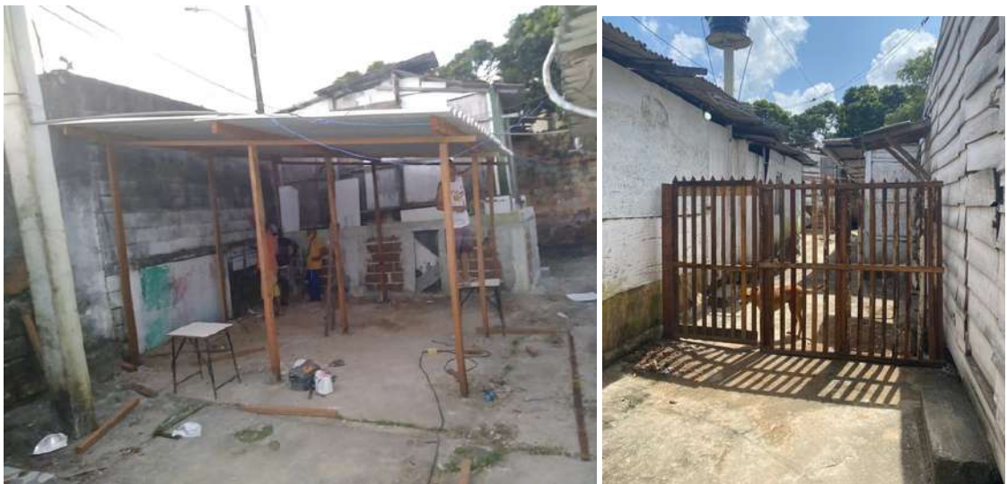
Figura 80: Processo de construção de cobertura e muro..
