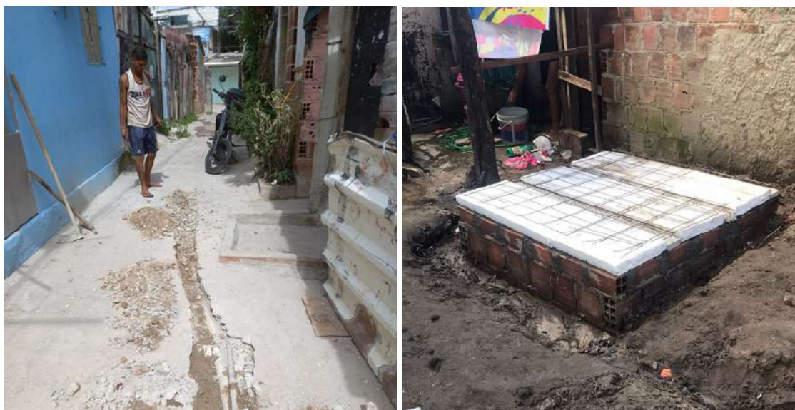
Figura 86: Construção de sistema de drenagem no Sítio..
