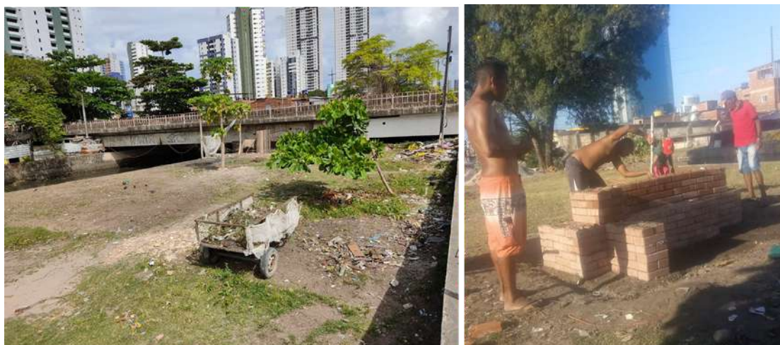
Figura 62 e 63: Vista da área do projeto na Fazendinha e construção do mobiliário de tijolo ecológico. Fonte: Setor de Arquitetura do MTST-PE.
