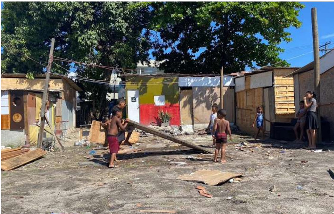
Figura 44: Mutirão de construção na 8M com a presença de crianças.
