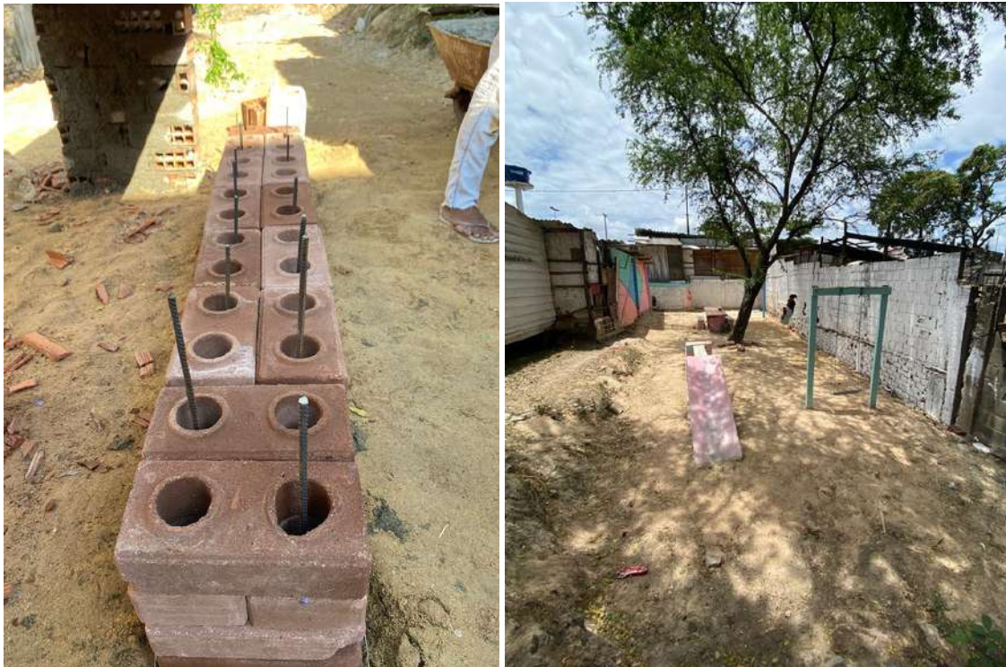
Figura 79: Processo de construção e brinquedos pronto na Carolina.
