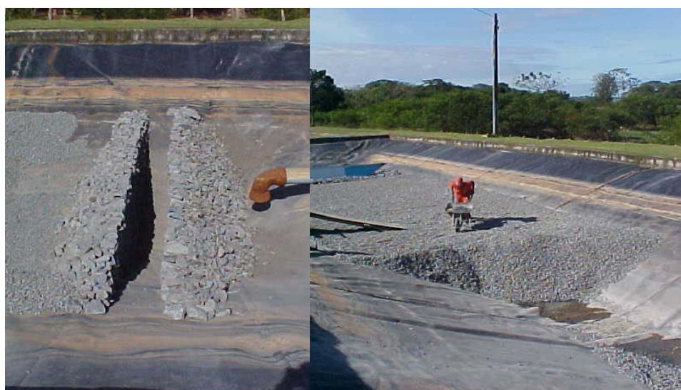
(a) pedras rachinha usadas para ancorar a barreira.
