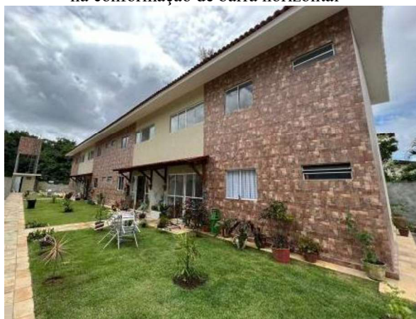
Figura 66 - Conjunto de casas geminadas na conformação de barra horizontal
