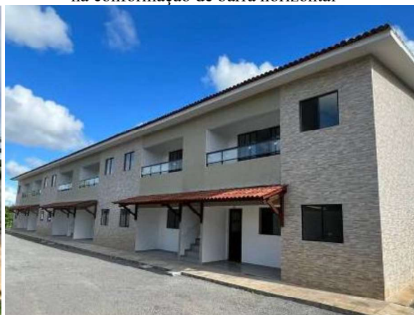
Figura 67 - Conjunto de casas geminadas na conformação de barra horizontal
