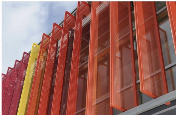
**Figura 64 e 65: Escola primária, Neubiberg, Alemanha. Projeto de referência para o sistema de brise chamado comercialmente de Shadometal, com material metálico perfurado instalado verticalmente para proteção solar, que permite a penetração da luz para fornecer iluminação natural.**
