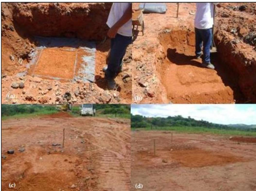
**Figura 56: Instalação do infiltrômetro da camada convencional (a) colocação de geotêxtil (b) compactação (c) compactação dos 20 cm finais (d) infiltrômetro instalado e camada reconstituída**
