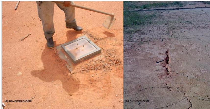
**Figura 124: Camada convencional em períodos secos e presença de fissuras**
