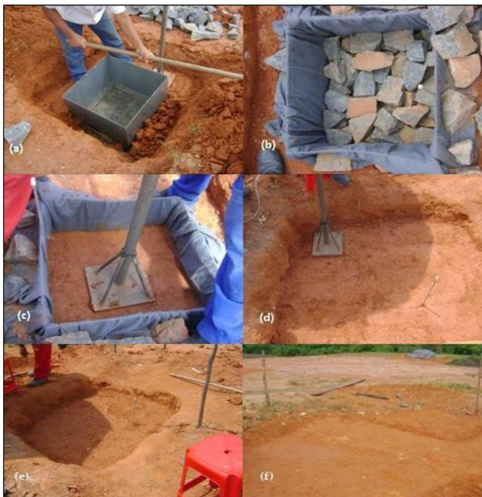
**Figura 55: Instalação do infiltrômetro da barreira capilar (a) colocação do geotêxtil (b) bloco capilar com pedra rachinha (c) preenchimento e compactação interna (d) e (e) compactação da camada superior (f) camada finalizada**
