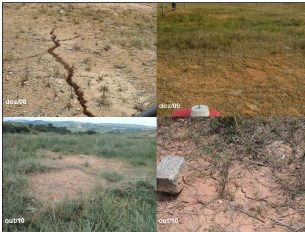
**Figura 86: Fissuras e presença de vegetação na camada de cobertura MET02**
