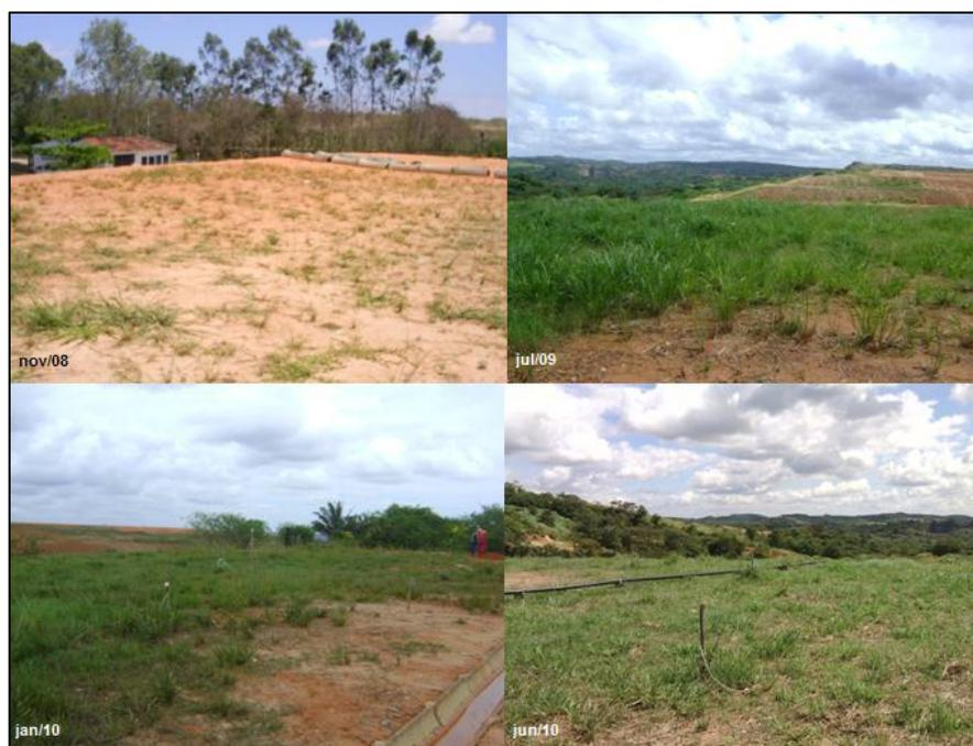
Figura 120: Presença de vegetação na barreira capilar em diversos períodos
