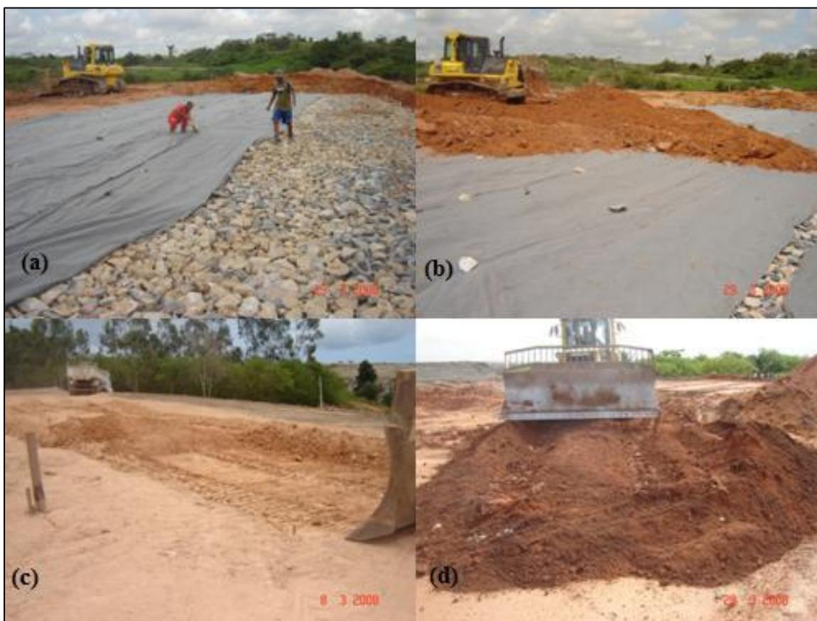
**Figura 36: (a) colocação de pedras rachinha e geotêxtil na base da barreira capilar (b) compactação da camada de solo na barreira capilar (c) regularização para colocação da camada metanotrófica acima do solo compactado (d) compactação da mistura de solo e composto**
