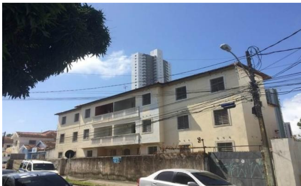
Fig 45: A Prédia/ Edifício Monte Castelo pouco antes da demolição em julho de 2018, já sem os moradores. Fonte: Jota Nogueira
