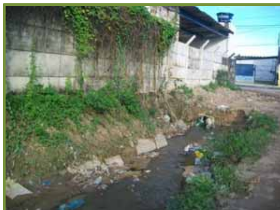
Foto 10 - Esgoto a céu aberto localizado no bairro de Aguazinha/Olinda-PE.
