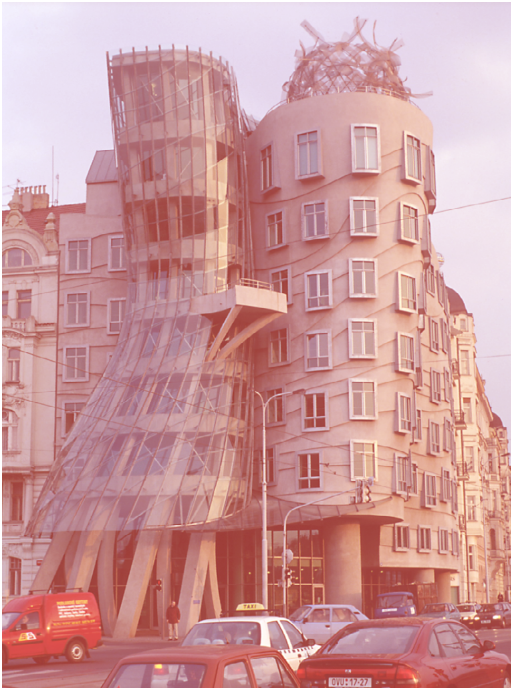
(F7) NATIONALE-NEDERLANDEN BUILDING , Frank Gehry Architects. A forma dinâmica e complexa da fachada é conseguida a partir do uso de tecnologias CAD/CAM de peças ligeiramente diferentes entre si. Fonte: https://archello.com .
