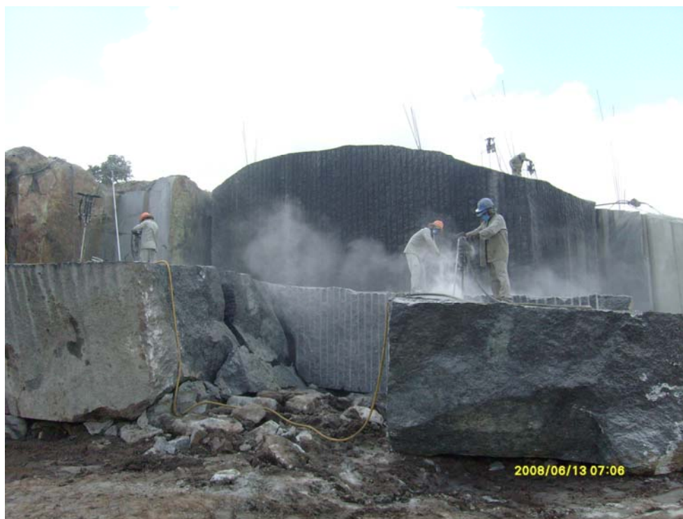
Foto 5 – Aspecto da frente de lavra da Corcovado Granitos Ltda, Fazenda das Pedras em Bom Jardim. Observar a bancada aberta através de fio diamantado, após detonação no plano de base da bancada (levante), como também o processo de desdobramento de blocos aparelhados.
