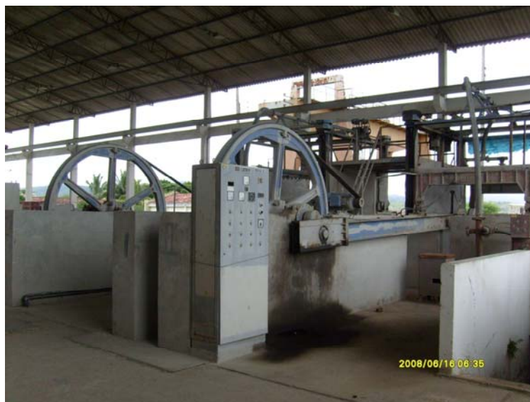
Foto 40 – Equipamentos (teares) desativados da Fuste – Fundações e Serviços Técnicos Ltda.
