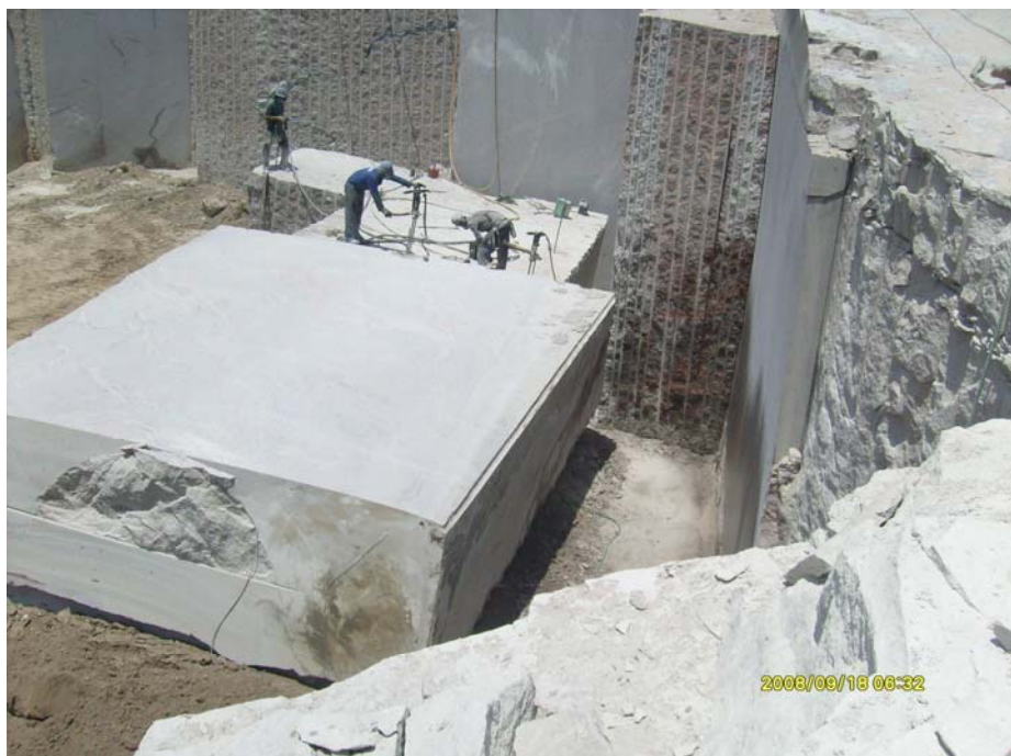
Foto 8 – Pedreira desenvolvida pela ATT - Mineração Ltda, na localidade do Sítio Jucá (Pedra). Notar a perfeição do corte feito por fio diamantado em uma prancha, que será desdobrada por marteletes.
