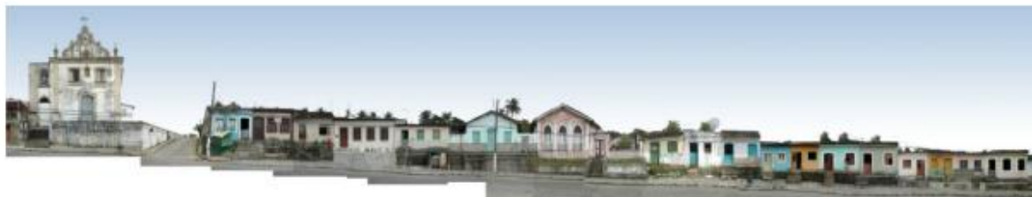
Figura 28 - Fotomontagem da rua Dr. Ladislau Neto com Igreja do Amparo e Beco do Amparo ao lado esquerdo. Percebe-se que as casas foram construídas sobre uma espécie de plataforma, em função das variações do nível da Lagoa Mangaba.
