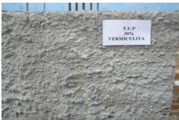
Figura - 42- Bloco de alvenaria chapiscado com placa de identificação de cada traço. (autor, 2007)
