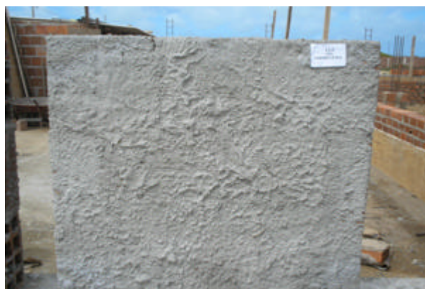
Figura 39 - Bloco de alvenaria com aplicação de Chapisco traço 1:3 (autor, 2007)
