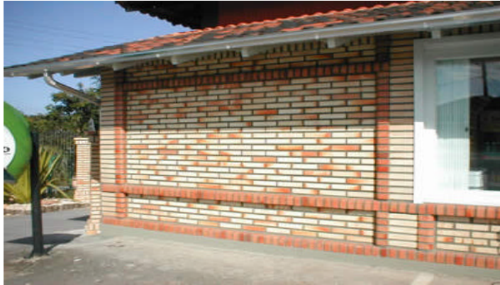
Figura 12 – Fachada de casa construída com blocos cerâmicos.
