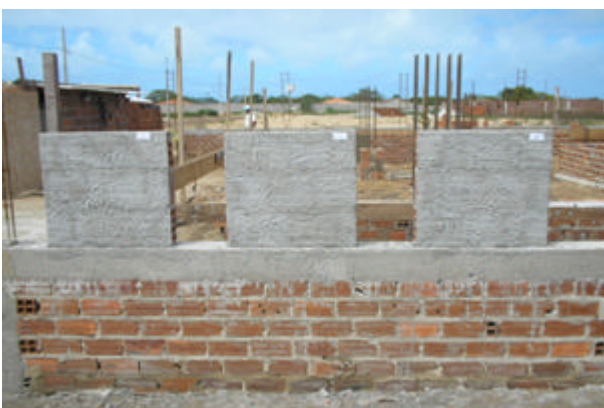
Figura 40 - Bloco de alvenaria (0,60x0,60) com Chapisco (autor, 2007)
