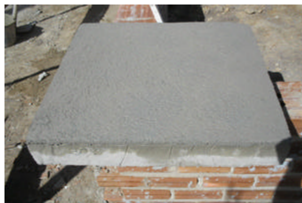
Figura - 43- Placa após revestimento com argamassa de 20mm de espessura (autor, 2007)
