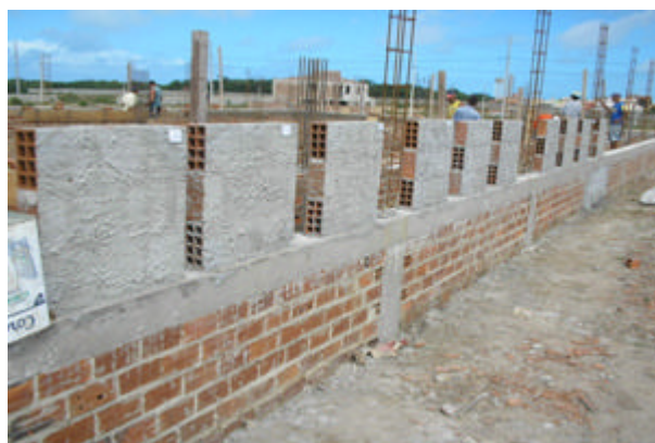
Figura 41 - Bloco de alvenaria com aplicação de Chapisco traço 1:3 (autor, 2007)
