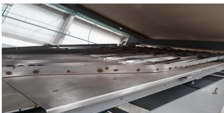
Figura 13 - Contenções no Redutor de fileiras.
