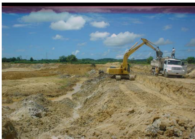
Fig. 3.5 – Operações unitárias de desmonte e de carregamento.
