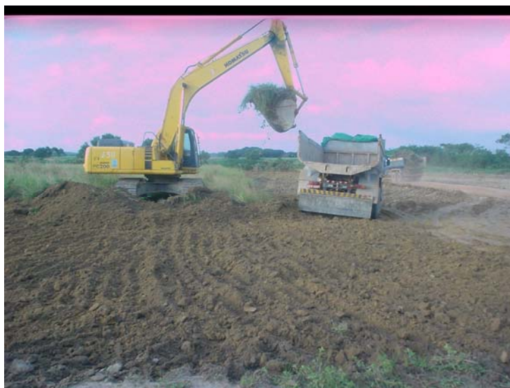
Fig. 3.8 – Decapeamento
