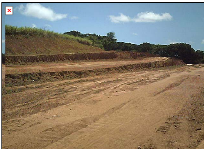
Fig. 3.9 – Depósito de material de empréstimo
