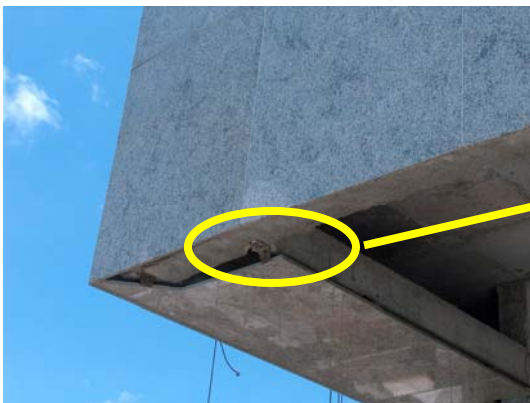
Figura 17: Oxidação precoce dos insertos metálicos
