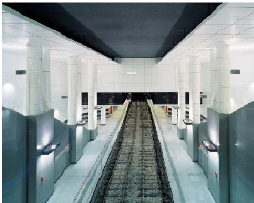
Figura 22: Revestimento interno e pavimentação do metrô em Dusseldorf, Alemanha
