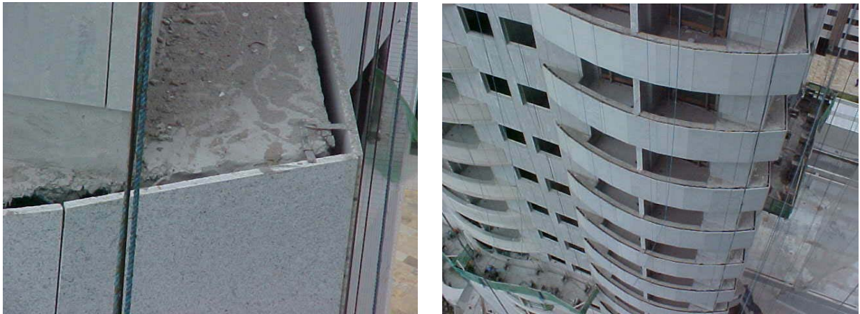
Figura 12 - Detalhe da fixação com "inserts" metálicos e vista superior da fachada do Edifício Flat Beira Mar, situado na cidade do Recife.
