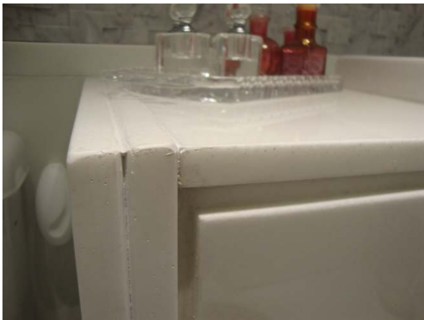
Figura 49: Aplicações de Marmoglass branco em bancada de banheiro
