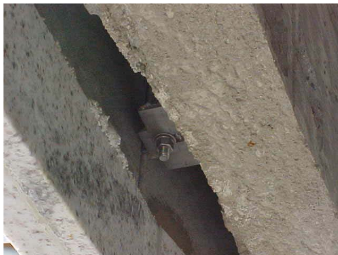
Figura 13 - Vista inferior de "insert" metálico de sustentação.
