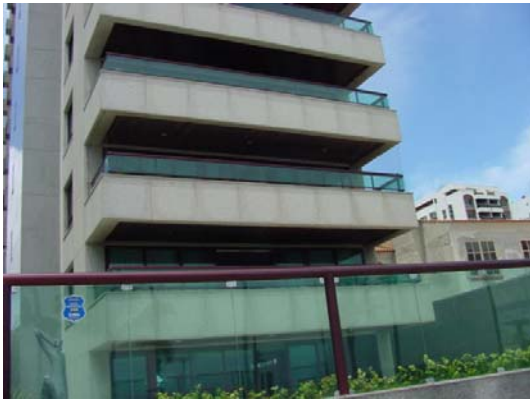
Figura 16: Manchamentos devido ao selante
