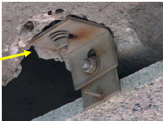
Figura 17: Oxidação precoce dos insertos metálicos
