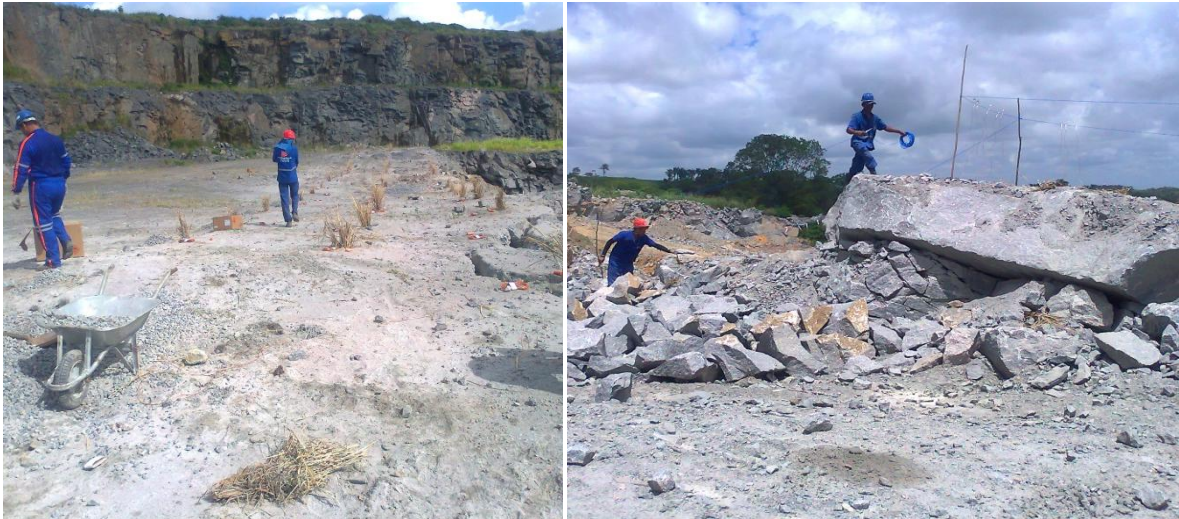
(a) Desmonte primário
