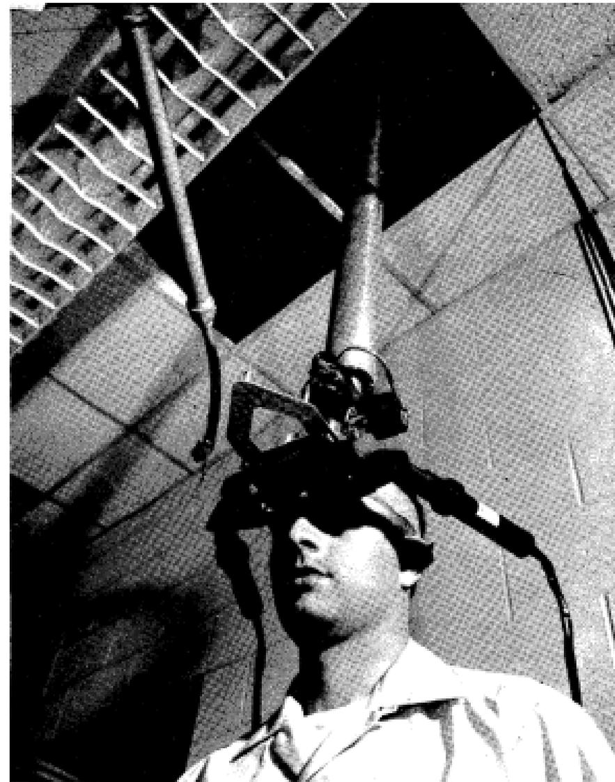
Imagem 6- Primeiro protótipo de dispositivo de Realidade Aumentada
