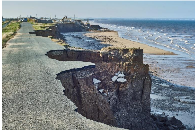
Figura 2- Destruição típica de margem por ação das ondas.
