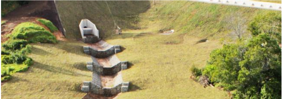
Figura 11 - Obra Hidráulica em gabião do tipo colchão integrado ao meio ambiente.
