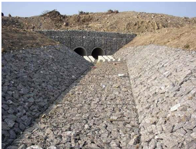
Figura 9- Canal revestido com revestimento flexível.
