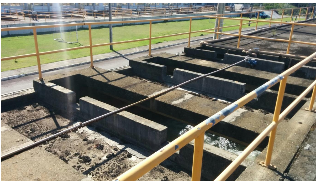
Figura 2 - Coaguladores na ETA Pirapama-PE.
