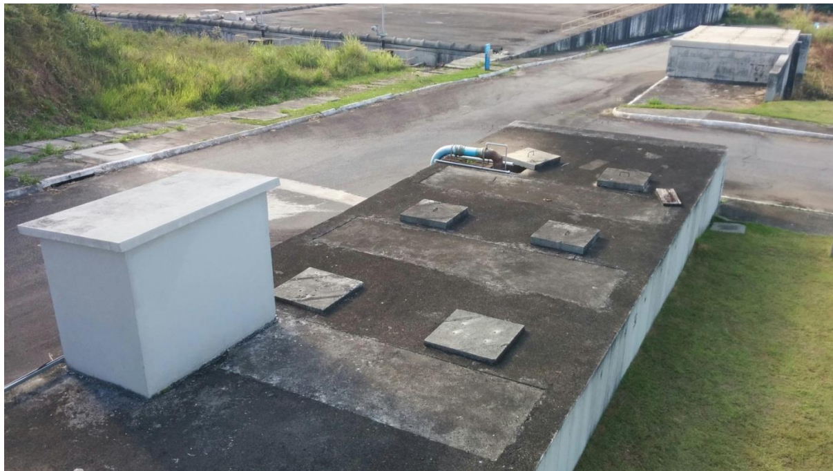
Figura 7 - Tanque de contato na ETA Pirapama-PE.
