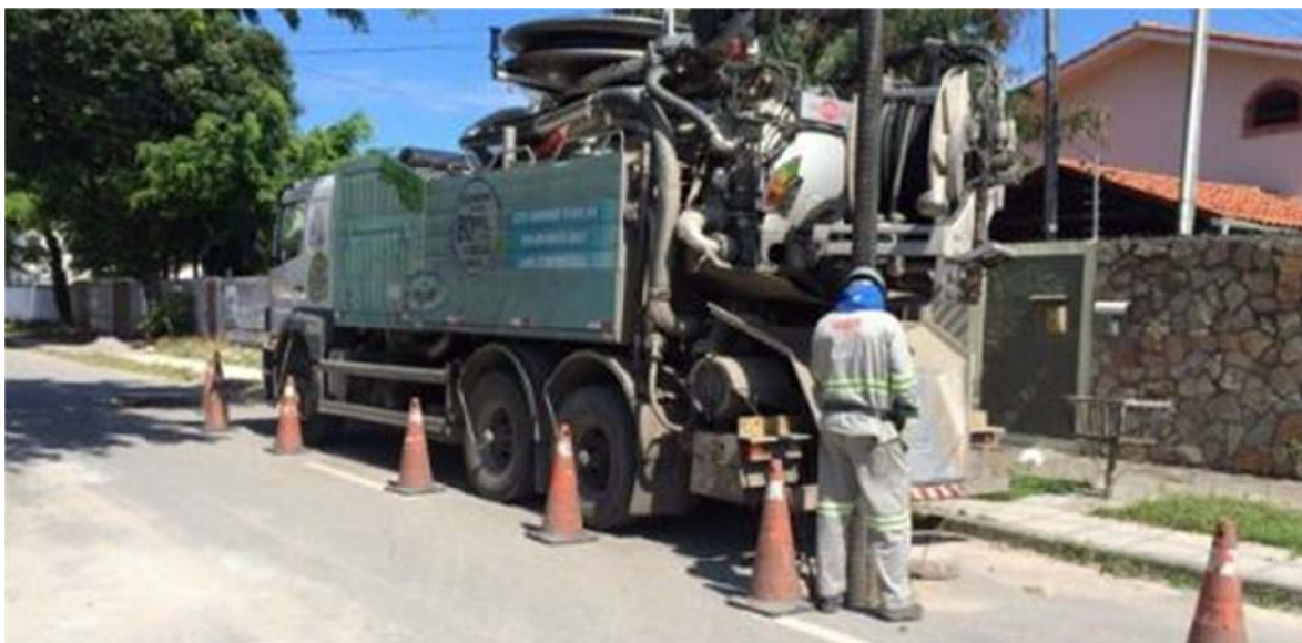
Figura 3 – Processo de desobstrução de rede coletora de esgoto
