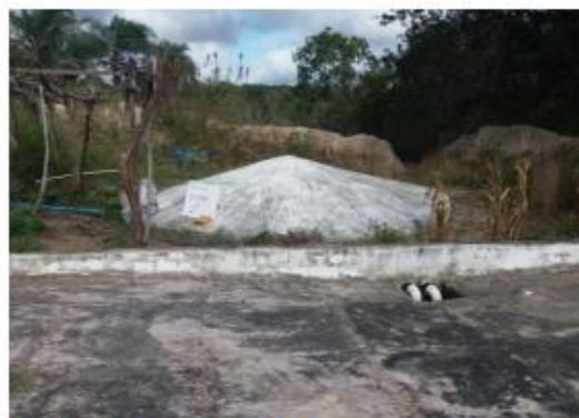
Figura 3. Cisterna Calçadão. Fonte: Maria A. F. dos Santos (2019).
