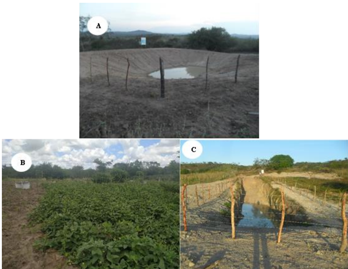
Figura 20 - Tecnologias implementadas no município de Serrinha-BA: barraginha (A), cisterna barragem subterrânea (B) e barreiro trincheira (C).
