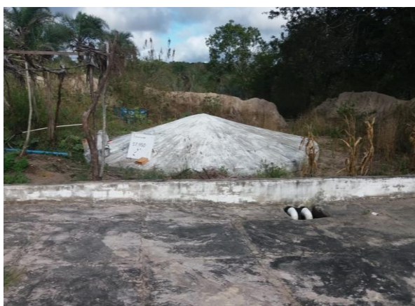
Figura 4 - Cisterna de placas.
