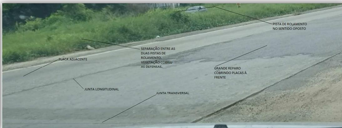
**Figura 2 - Ilustração de placas, juntas, separação das pistas de rolamento e grande reparo.**
